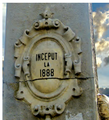
Fig. 4.29 Portalul de ieșire, pilastrul din amonte cu inscripționarea anului de începere a lucrărilor
