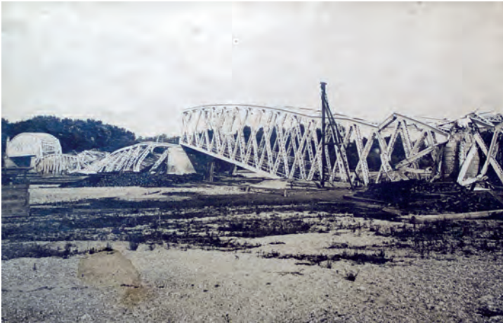
Fig.4.32. Tablierele din deschiderile 2, 3, 4 dinamitate de trupele române în 1916. Tablierele din deschiderile 1 și 5 au rămas pe poziție, nefiind dinamitate
