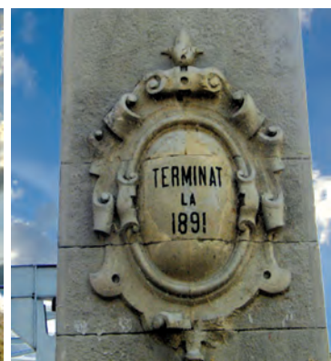
Fig. 4.30 Portalul de ieșire, pilastrul din aval cu inscripționarea anului de inaugurare a lucrărilor
