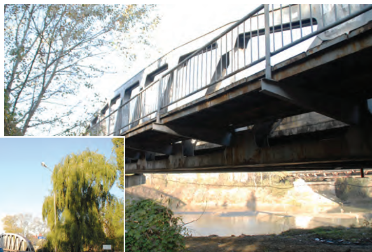
Nodurile grinzii cu zăbrele cale jos sunt atacate de rugină!
