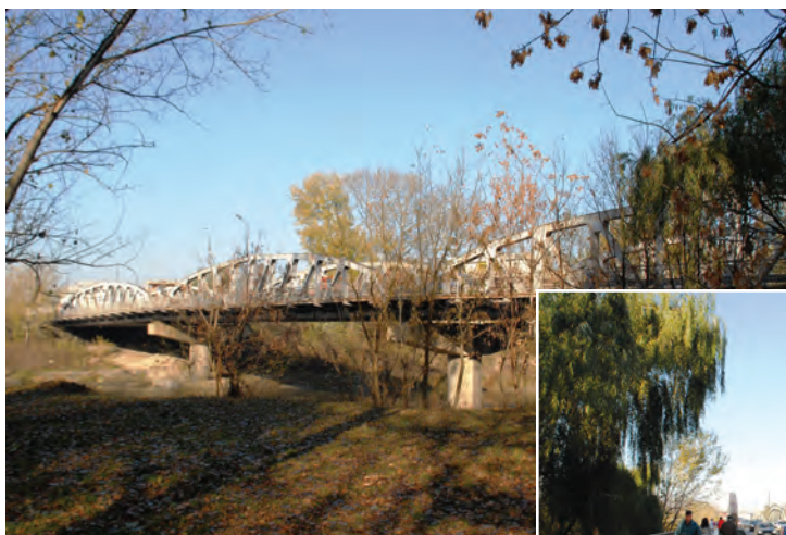
Elevația podului văzută din amonte
