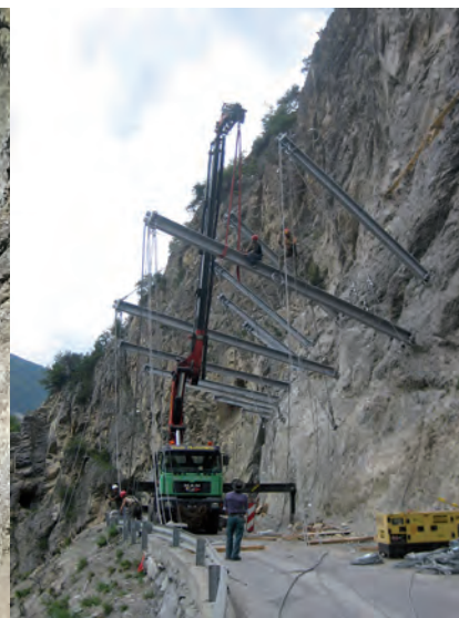
Instalarea celui mai lung stâlp având 11 m lungime
