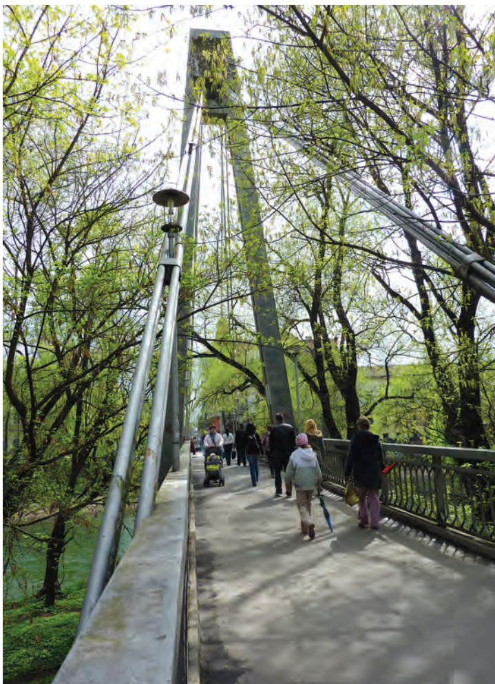
Pasarela de pe Crișul Repede - Oradea
