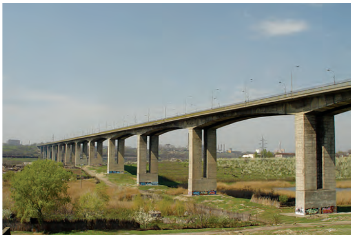
Lucrare de artă - unicat; Viaductul Cătușa, de la Galați
