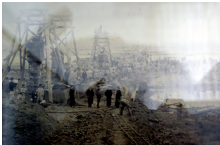
Fig. 4.24 Imagine din timpul execuției podului de lemn Colecția Muzeului județului Olt
