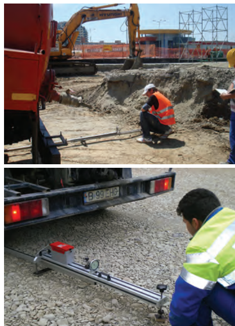
Fig. 27 Verificarea capacității portante cu pârghia Benkelman
