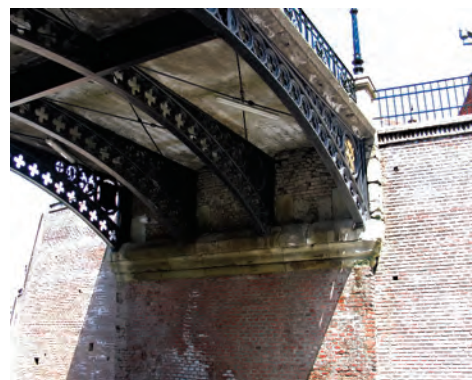
Fig. 4.19 Detaliu de rezemare a grinzilor de fontă. Foto Sabin Florea
