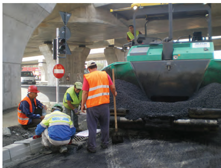
Fig. 25 Așternere asfalt pe drumurile de sub pasaj
