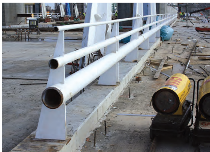
Fig. 11 și 12 Parapet direcțional
