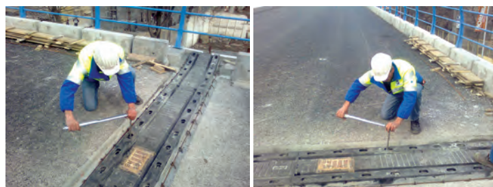
Fig. 13 și 14 Strângerea buloanelor la rosturi de dilatație cu cheia dinamometrică
