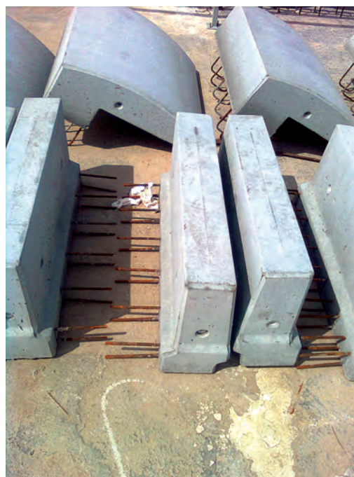
Fig. 2 Elemente de bordură și lisă prefabricate în șantier
