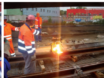
Fig. 21 Sudura aluminotermică
