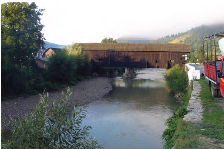
Fig. 4.14 Elevația podului de lemn acoperit, văzută din amonte de pe malul drept al râului Sălăuța din comuna George Coșbuc. Foto Sabin Florea
