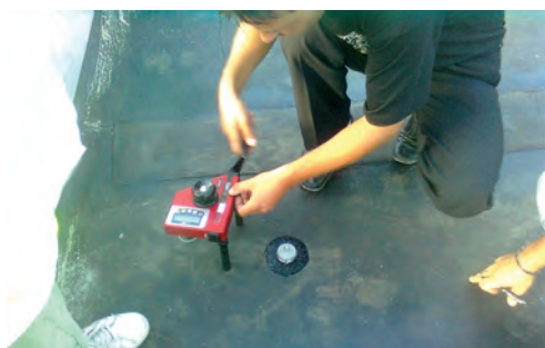
Fig. 1 Verificarea hidroizolației prin măsurarea adhezivității la tracțiune (min. 0,5 N/mm 2 )
