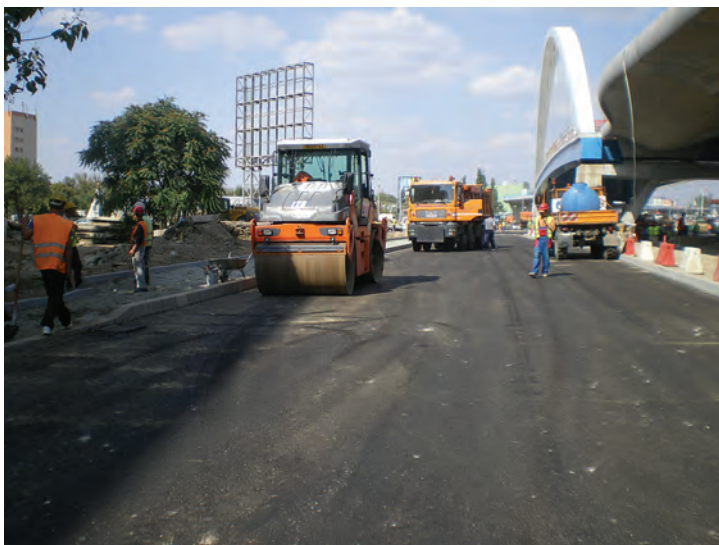
Fig. 26 Executarea compactării după asfaltare
