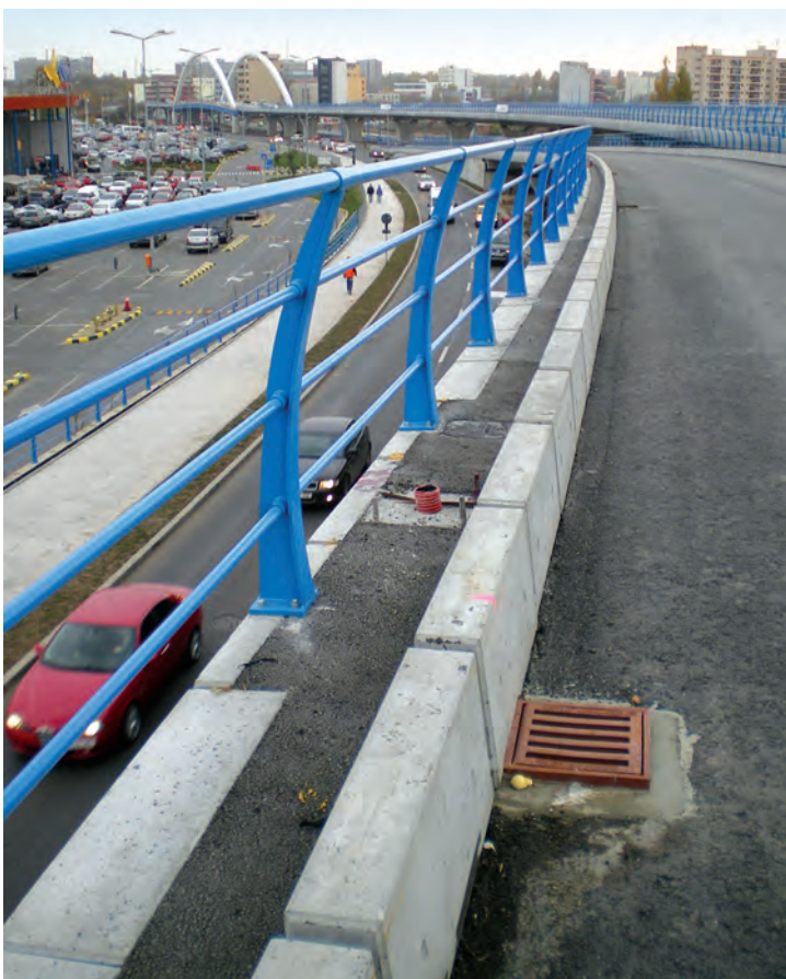
Fig. 16 Gură de scurgere înainte de turnarea stratului de uzură
