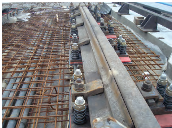
Fig. 19 Aparate de compensare
