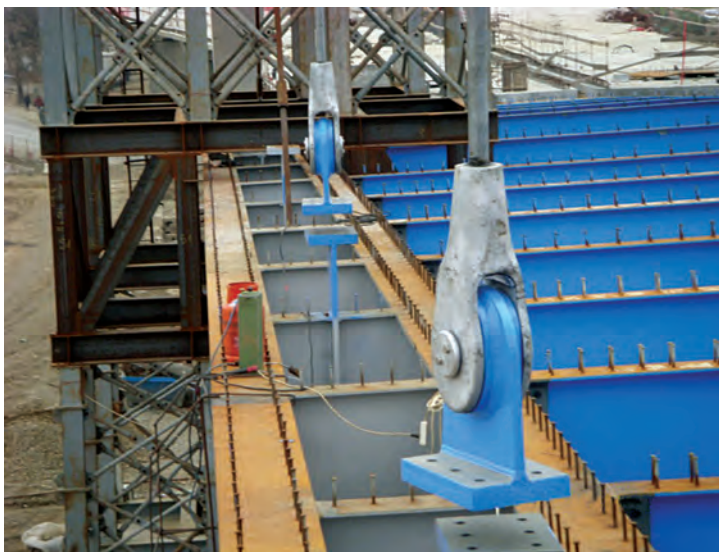
Fig. 6 Tiranți verticali ai arcelor
