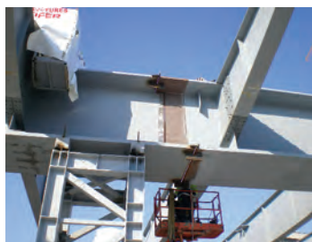
Fig. 9 Îmbinare grindă transversală cu grindă longitudinală
