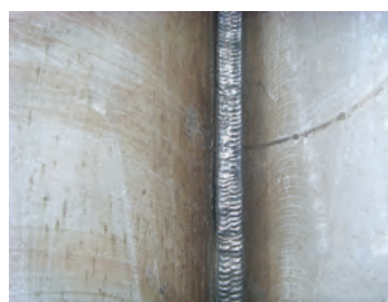
Fig. 18 Sudură realizată cu arc electric cu electrod bazic
