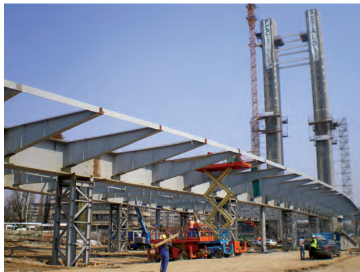
Fig. 14 Montare tablier între PS4 și PC2 pe eșafodaje metalice
