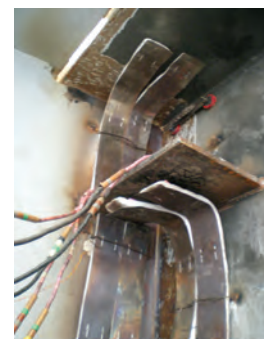
Fig. 17 Preîncălzire cu plăpumi din rezistențe electrice calibrate
