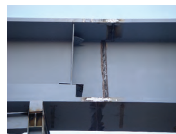
Fig. 19 Sudură realizată cu arc electric în mediu de gaz protector cu sârmă tubulară
