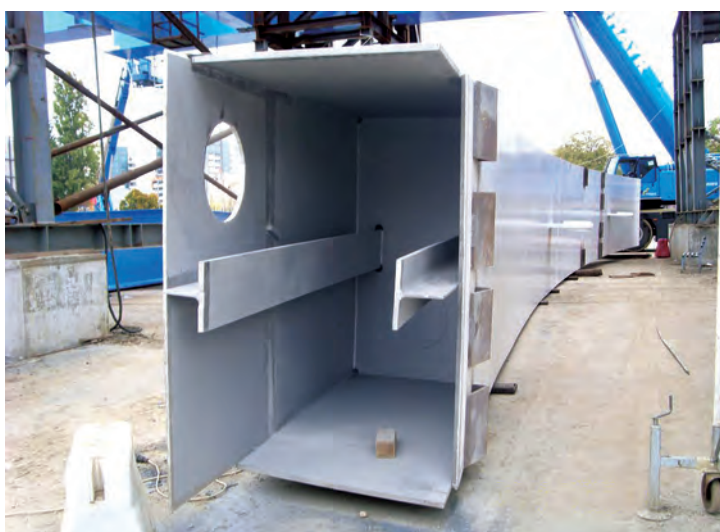
Fig. 2 Tronson de arc cu secțiunea cheson închis
