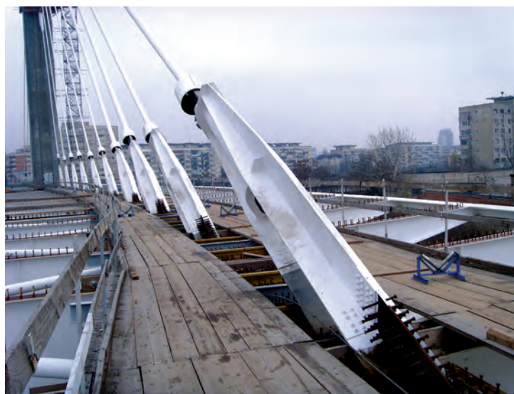
Fig. 13 Dispozitive în care se montează ancorajele hobanelor
