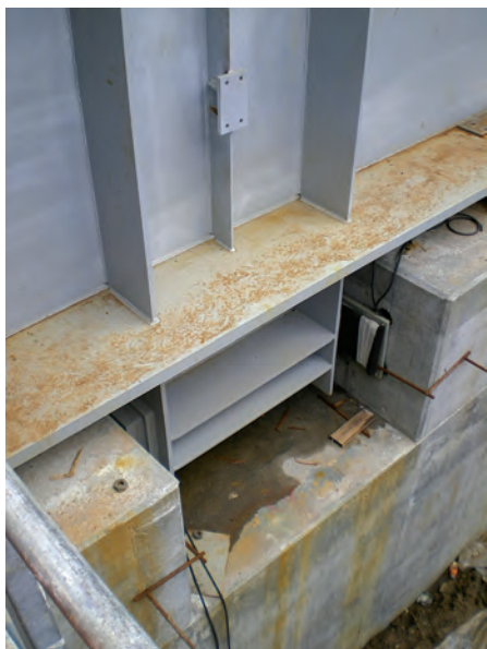
Fig. 12 Cioc pentru fixarea tablierului în riglă
