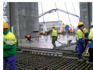
Fig. 26 Turnare placă de suprabetonare
