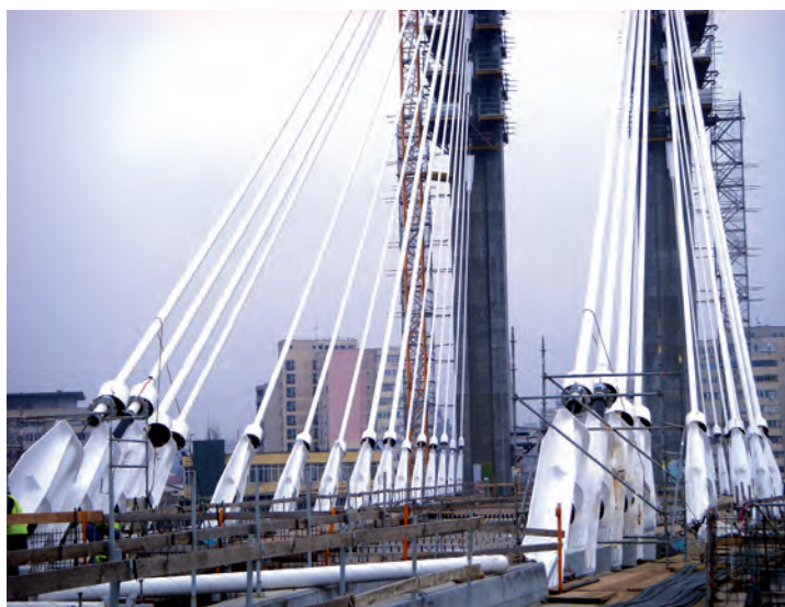
Fig. 11 Hobane pentru susținerea tablierului
