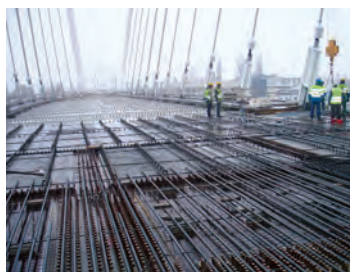
Fig. 25 Montare predale din beton armat
