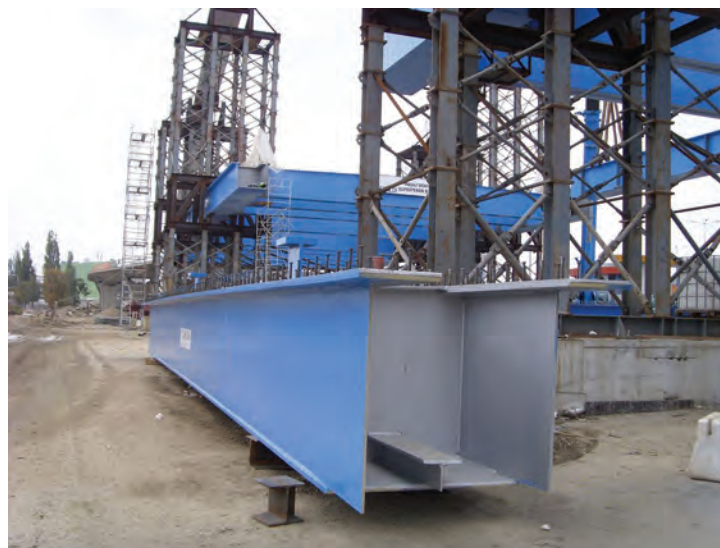
Fig. 3 Grindă cheson deschis la partea superioară
