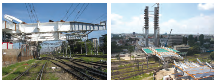
Fig. 15b Tronsoane de tablier peste calea ferată
