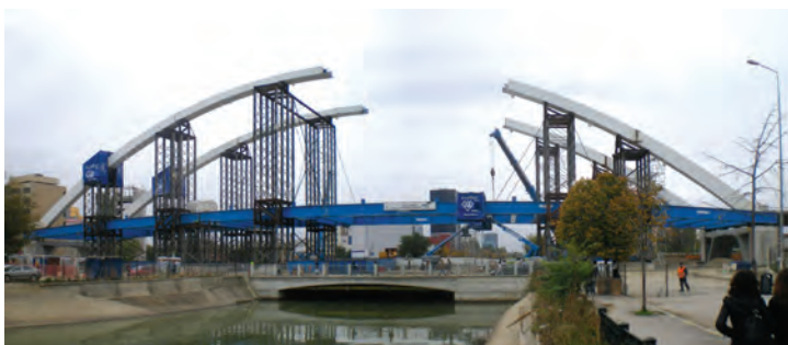
Fig. 7 Montare pod pe arce peste râul Dâmbovița
