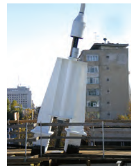
Fig. 24 Detaliu prindere hobană
