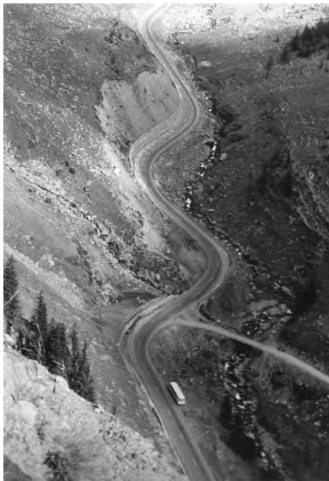
Transfăgărășan Sud, km 108 - 109
