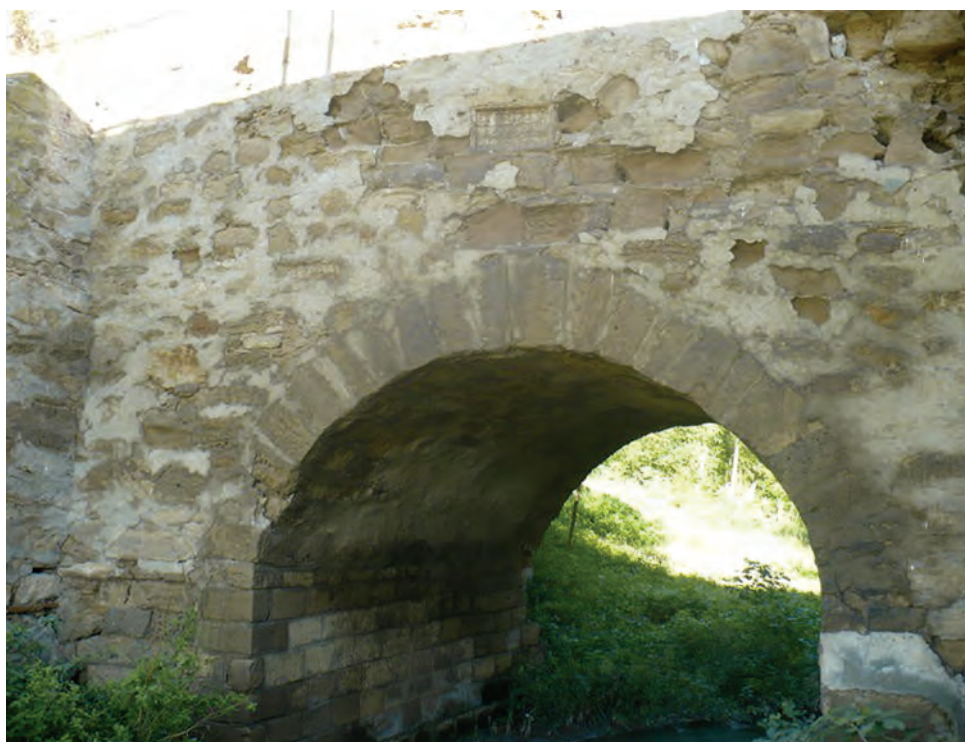
Fig. 3-25. DN 15 D Roman - Vaslui km 116 + 500. Vechiul pod medieval la Căntălărești (foto Loredana)
