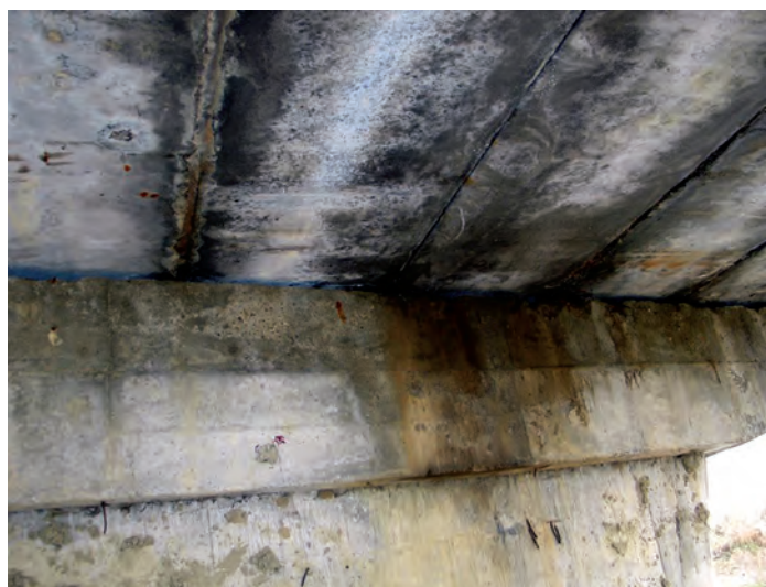
Intradosul suprastructurii beton armat precomprimat (grinzi fâșii cu goluri)
