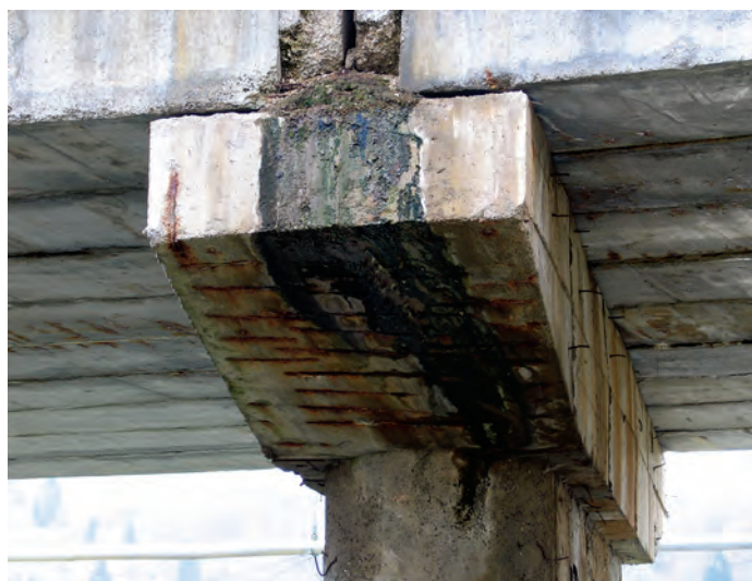
Pila nr 1 văzută din amonte de pe malul drept al râului Buzău
