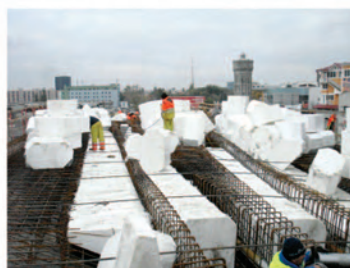
Fig. 10 Umplerea golului de casetă cu blocuri din polistiren expandat
