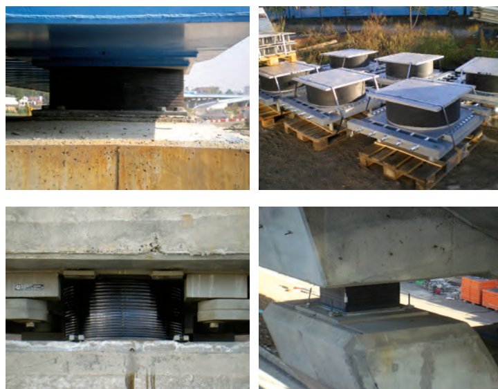
Fig.4 Aparate de reazem tip LRB
