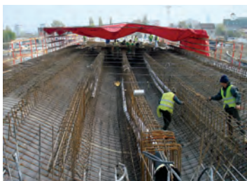
Fig. 16 Montarea tecilor pe stele din oțel beton
