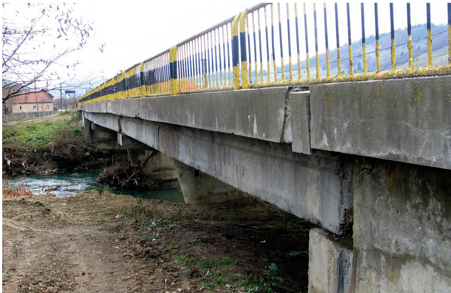
Intradosul suprastructurii beton armat precomprimat (grinzi fâșii cu goluri)
