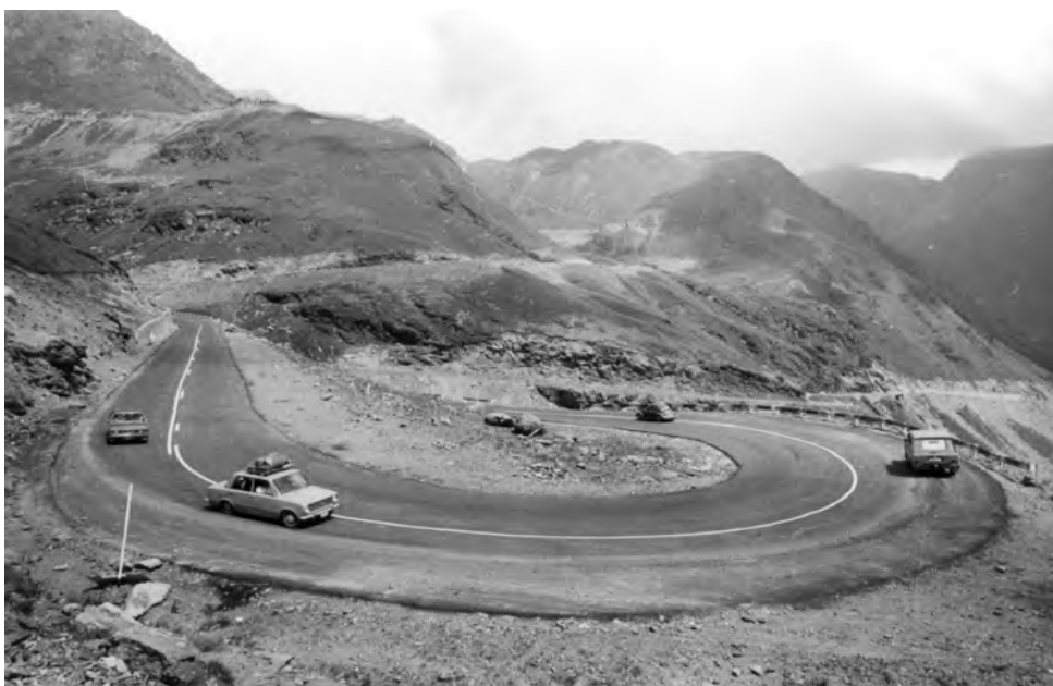
Transfăgărășan Sud, km 111 - 114 (1983)
