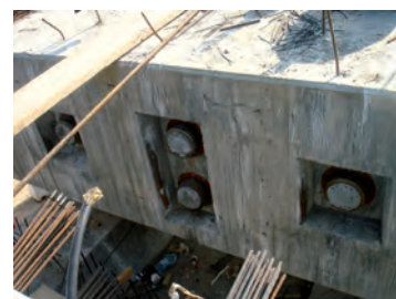
Fig. 18 Ancoraje pentru conuri active, respectiv pasive
