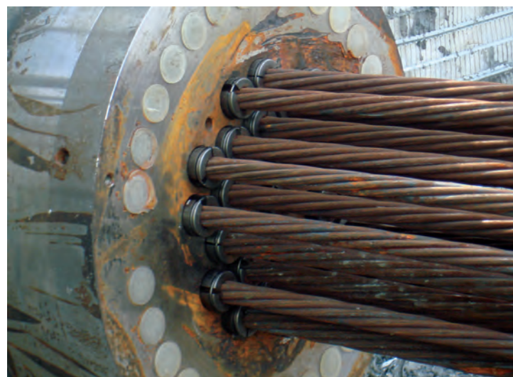
Fig. 14 Cablu de precomprimare format din 27 de toroane
