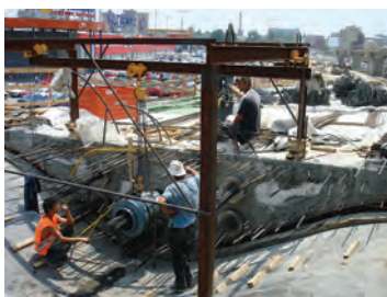
Fig. 17 Precomprimarea cablurilor
