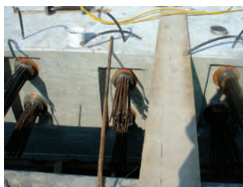
Fig. 18 Ancoraje pentru conuri active, respectiv pasive
