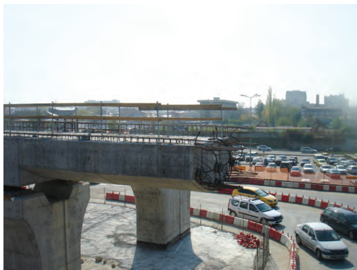
Fig. 11 Final tronson tablier tramvai precomprimat (7,00 m de la reazem)
