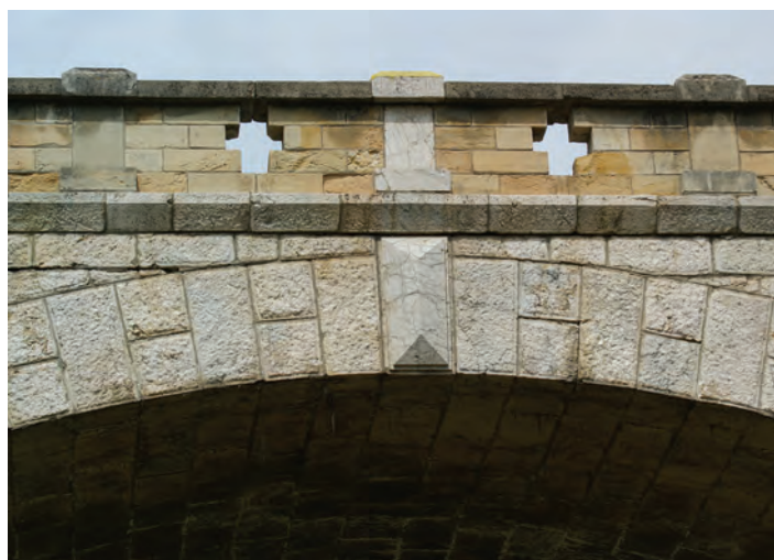
Fig. 4.44 Detaliul elevației aval a cheii bolții. (fotografie S. Florea)
