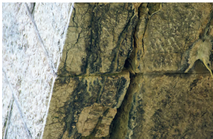
Fig. 4.53 Detaliu cu intradosul bolții – timpanul din amonte. (Foto S. Florea 2011)
