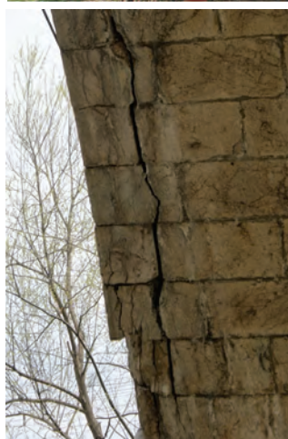
Fig. 4.50 Intradosul bolții la nașterea de pe malul stâng al râului Dâmbovița. De această dată nu mai este necesară lupa, apariția fenomenului de voalare a timpanului (desprinderi ale timpanului de boltă) sunt vizibile cu ochiul liber (crăpături cu deschideri de ordinul centimetrilor). Imagini luate în aceeași poziție din anul 2007, după 4 ani, în anul 2011 luna aprilie ziua 27 (Foto S. FLOREA).
