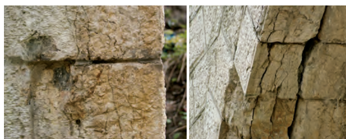
Fig. 4.50 Intradosul bolții la nașterea de pe malul stâng al râului Dâmbovița. De această dată nu mai este necesară lupa, apariția fenomenului de voalare a timpanului (desprinderi ale timpanului de boltă) sunt vizibile cu ochiul liber (crăpături cu deschideri de ordinul centimetrilor). Imagini luate în aceeași poziție din anul 2007, după 4 ani, în anul 2011 luna aprilie ziua 27 (Foto S. FLOREA).
