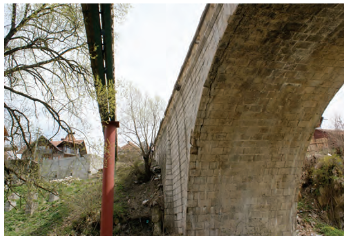
Fig. 4.50 Intradosul bolții la nașterea de pe malul stâng al râului Dâmbovița. De această dată nu mai este necesară lupa, apariția fenomenului de voalare a timpanului (desprinderi ale timpanului de boltă) sunt vizibile cu ochiul liber (crăpături cu deschideri de ordinul centimetrilor). Imagini luate în aceeași poziție din anul 2007, după 4 ani, în anul 2011 luna aprilie ziua 27 (Foto S. FLOREA).
