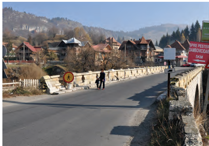
Fig. 4.56 Urmările unui transport agabaritic. (Foto Emil JIPA)
