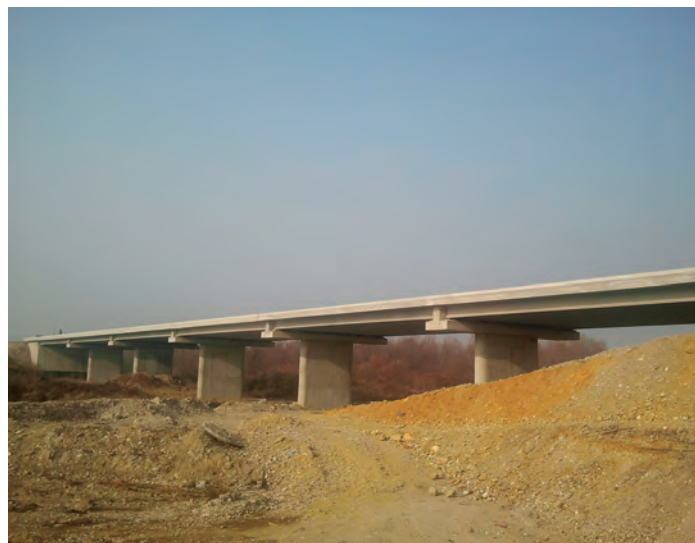
Pod peste râul Timiș - km 11+299(2)
