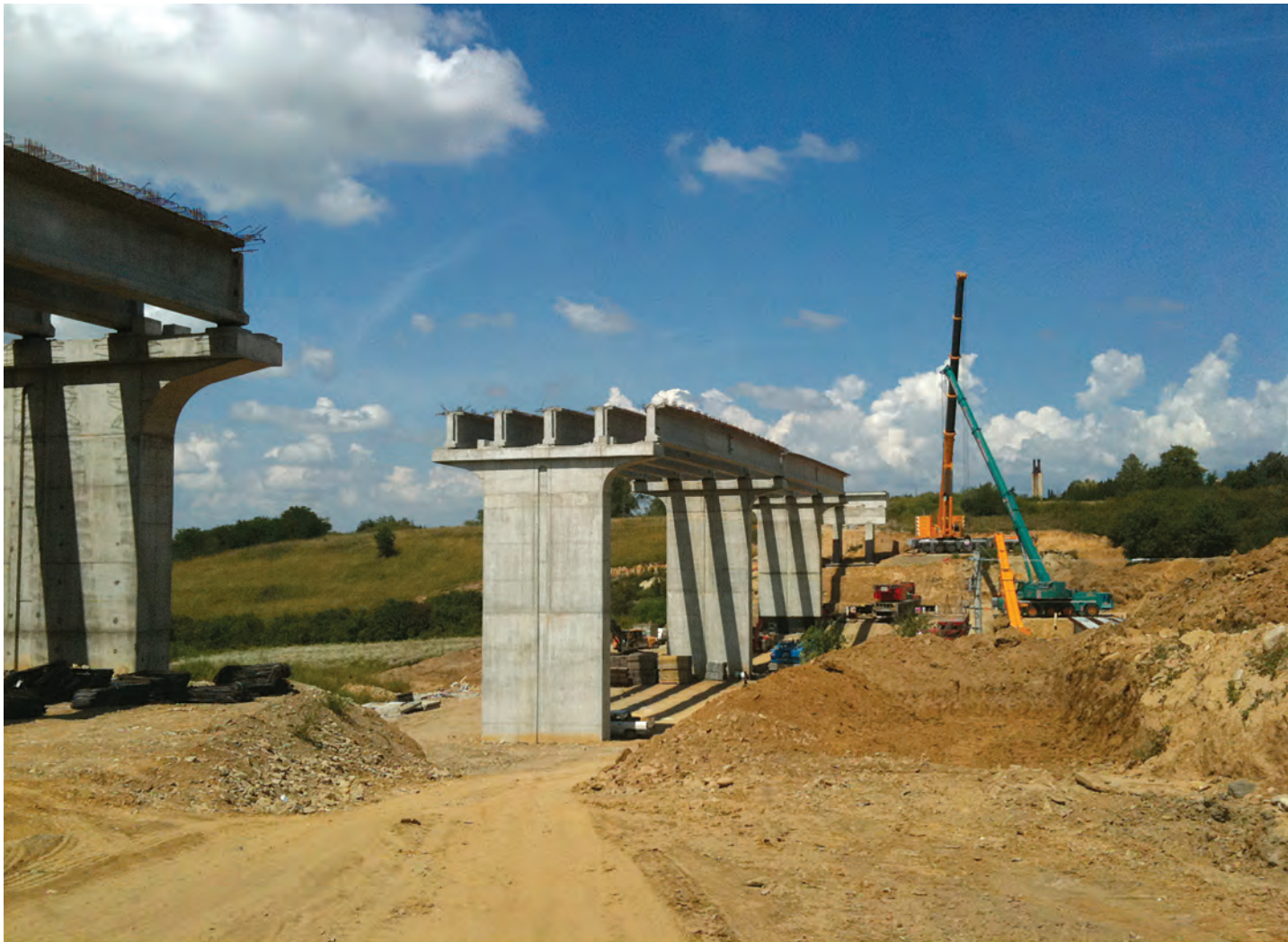
Viaduct peste Valea Potocului - km 5+512
