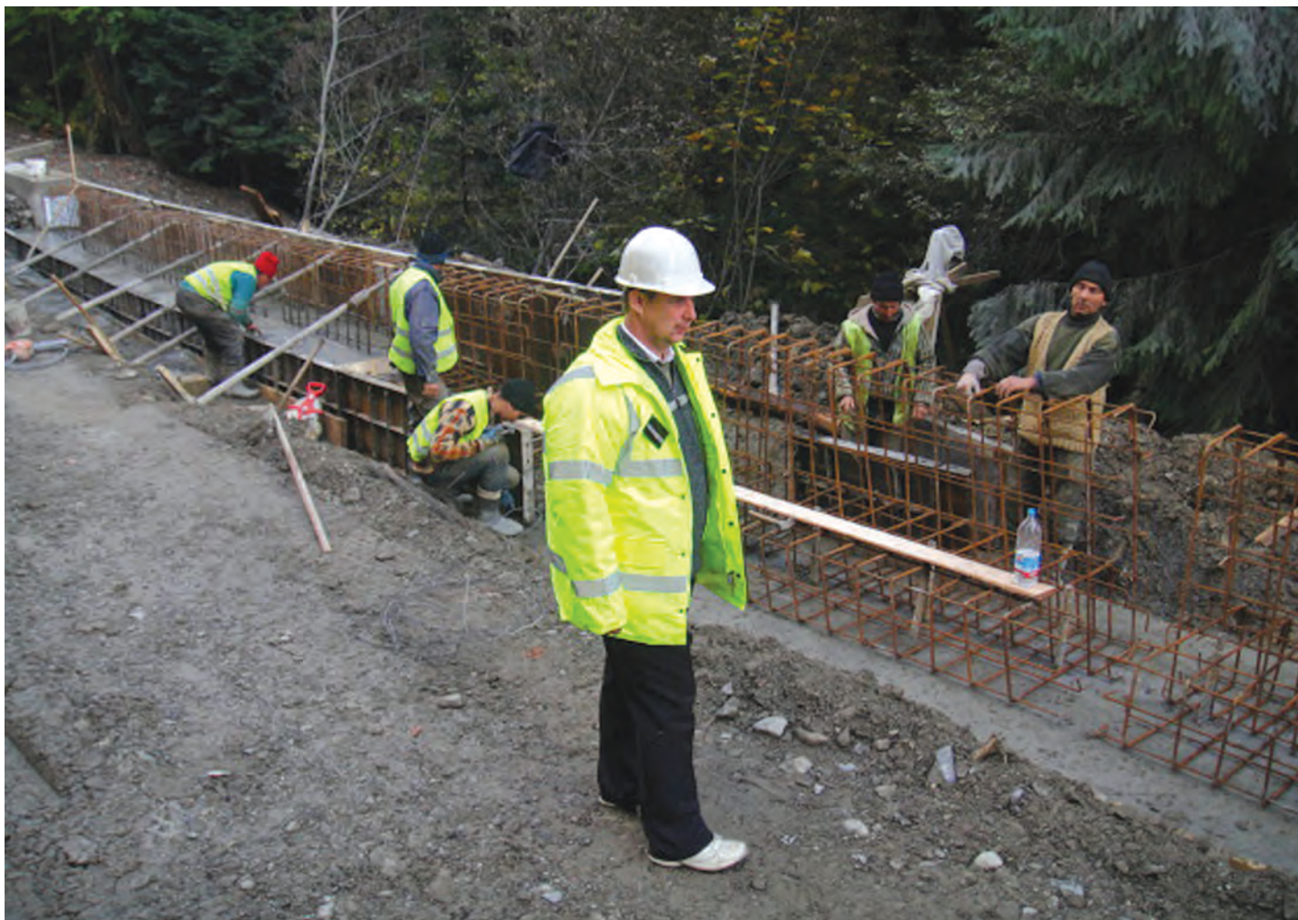
Lucrări de construcție a drumului înseamnă folosirea tehnologiei adecvate, precum și controlul făcut permanent de către personalul tehnico-ingineresc. Domnul inginer Volodia MACAROV examinează armătura zidului de sprijin.
