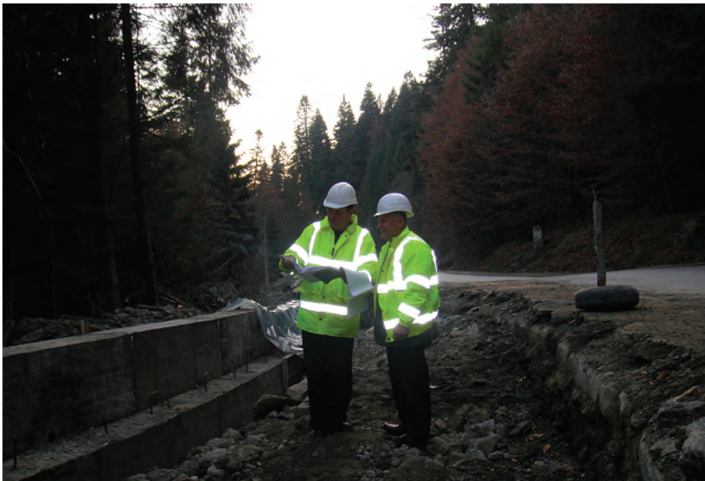
Verificarea execuției la consolidarea Șoselei Naționale care leagă localitatea Poiana Largului de Târgu Neamț
