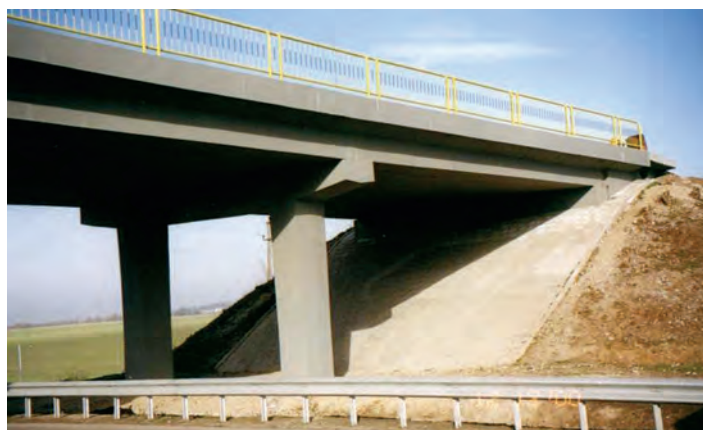
Fig. 2 Pasaj reabilitat peste Autostrada A1
