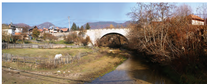
Fig. 4.34 Podul Dâmboviței, o splendidă boltă în plin cintru, dublu încastrată cu timpane, realizată din zidărie de piatră cioplită, piatră din Albeștii de Muscel.
