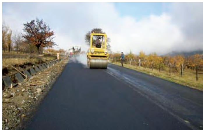
Figura 5 - Aspectul sectorului experimental realizat
