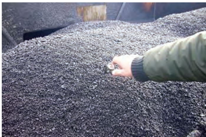
Figura 3 - Aspectul mixturii asfaltice la punerea în operă și măsurarea temperaturii înainte de așternerea și compactarea mixturii asfaltice
