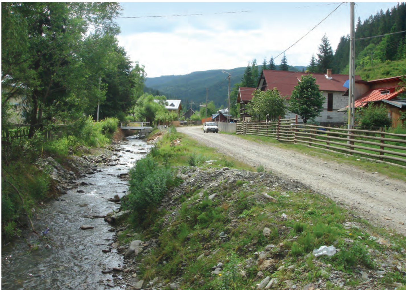
Imagine a drumului înainte de modernizare
