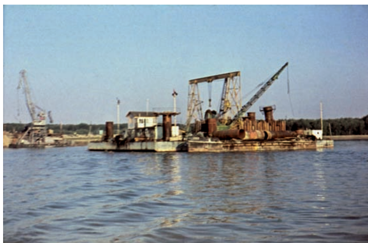
Foto 5. Platforma de lucru la pile albie
