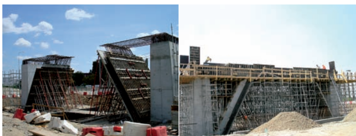
Fig. 7. Cofraj și eșafodaj la pila culee PS2
