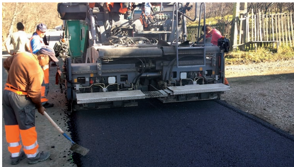
Firma are complexul de lucrări pentru modernizarea DJ 142 C (Coroi - Vișoara) pe o lungime de 20,225 km
