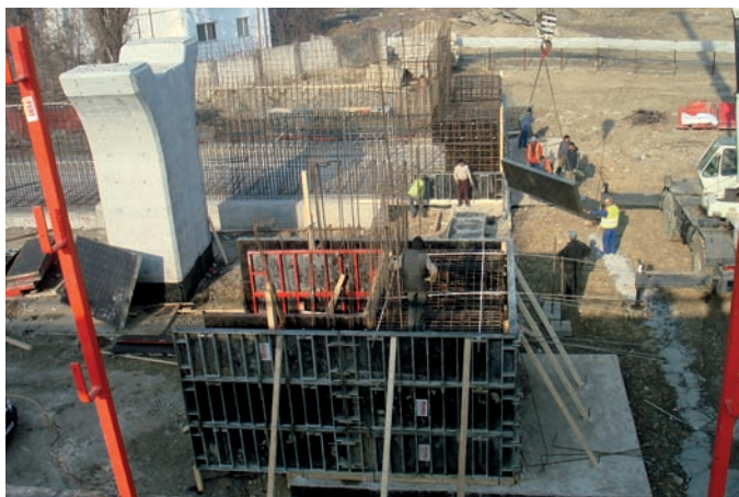
Fig. 39. Zid de sprijin rampă coborâre auto
