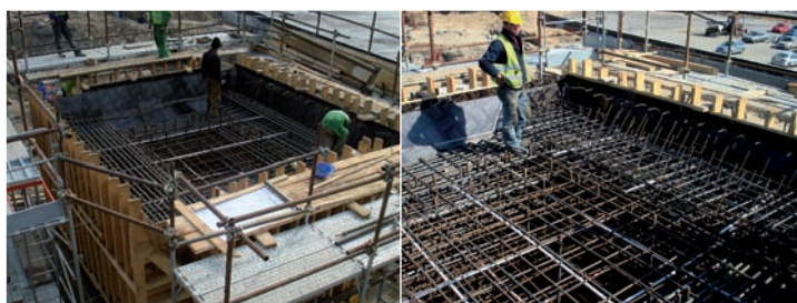
Fig. 17. Armare pilă ciupercă
