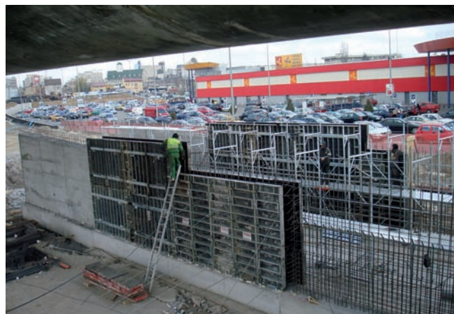
Fig. 40. Zid de sprijin rampă
