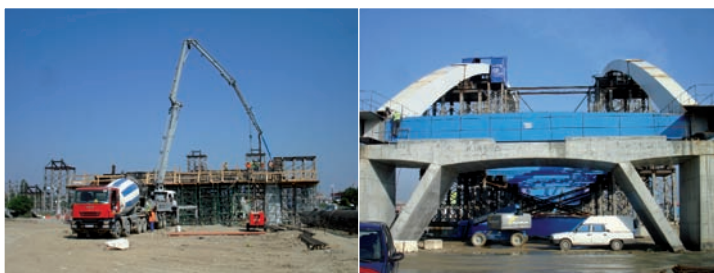
Fig. 8. Betonare pila culee PS1
