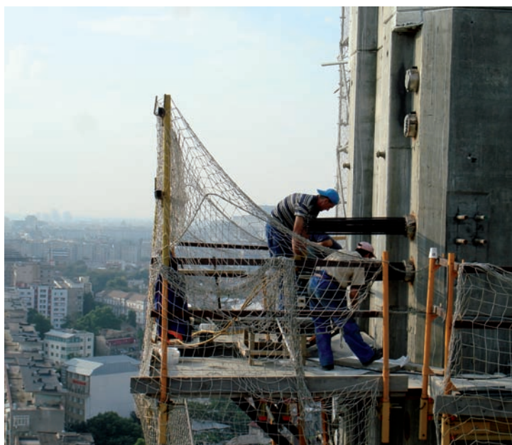
Fig. 21. Precomprimare transversală în zona ancorajelor din stâlpi
