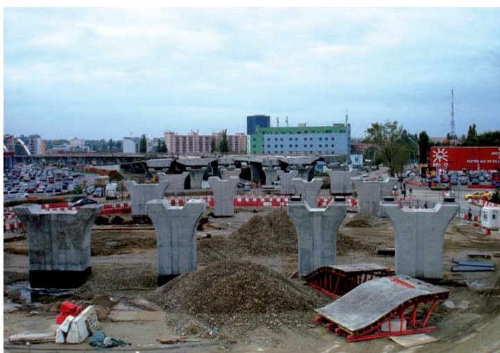
Fig. 1. Elevații pile viaducte Orhideea
