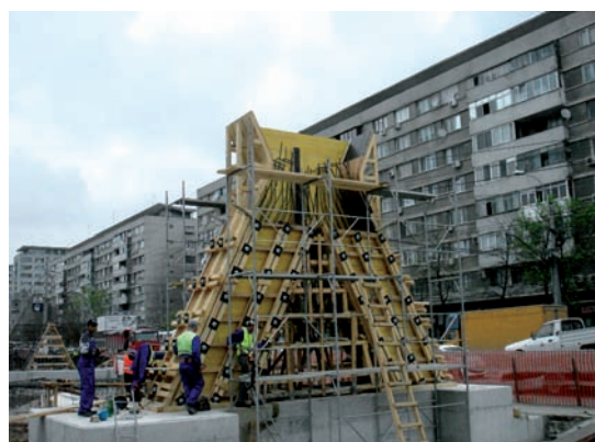
Fig. 33. Cofrare pile la rampa de urcare Grivița
