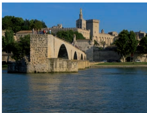
Fig. 3-03. Ruinele podului medieval construit peste Ron la Avignon
