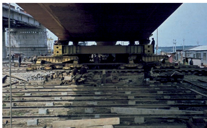
Foto 10. Ripare tablier 1750 t
