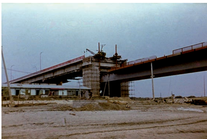
Foto 17 -18. Montajul și ridicarea blocului de 91,50 m
