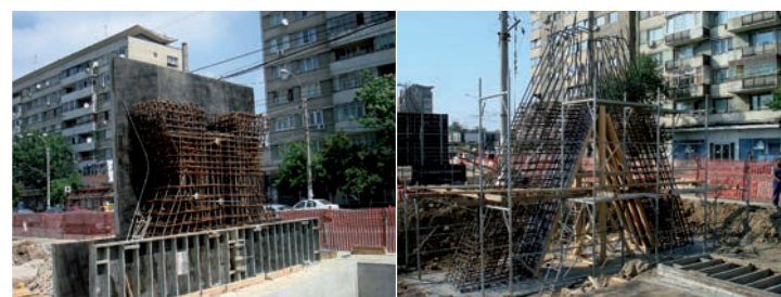
Fig. 32. Armare pile la rampele de urcare și de coborâre Grivița
