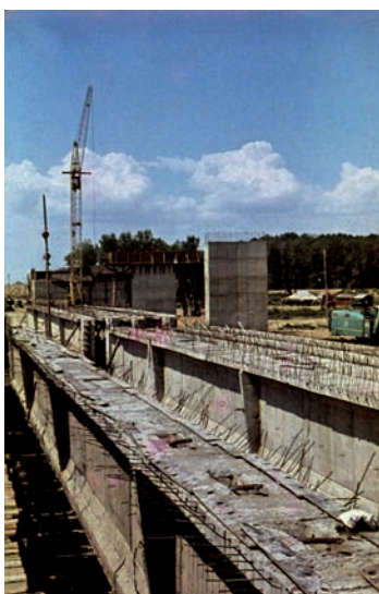
Foto 1. Platforma de turnare
