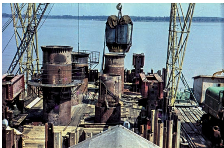
Foto 6. Execuția coloanelor cu diametrul de 1,96 m
