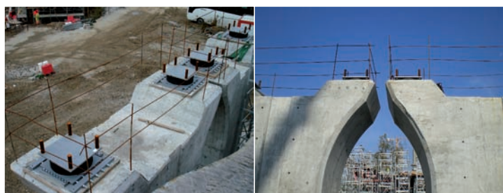
Fig. 2. Bancheta cuzineților pe care sunt montate aparate de reazem din neopren
