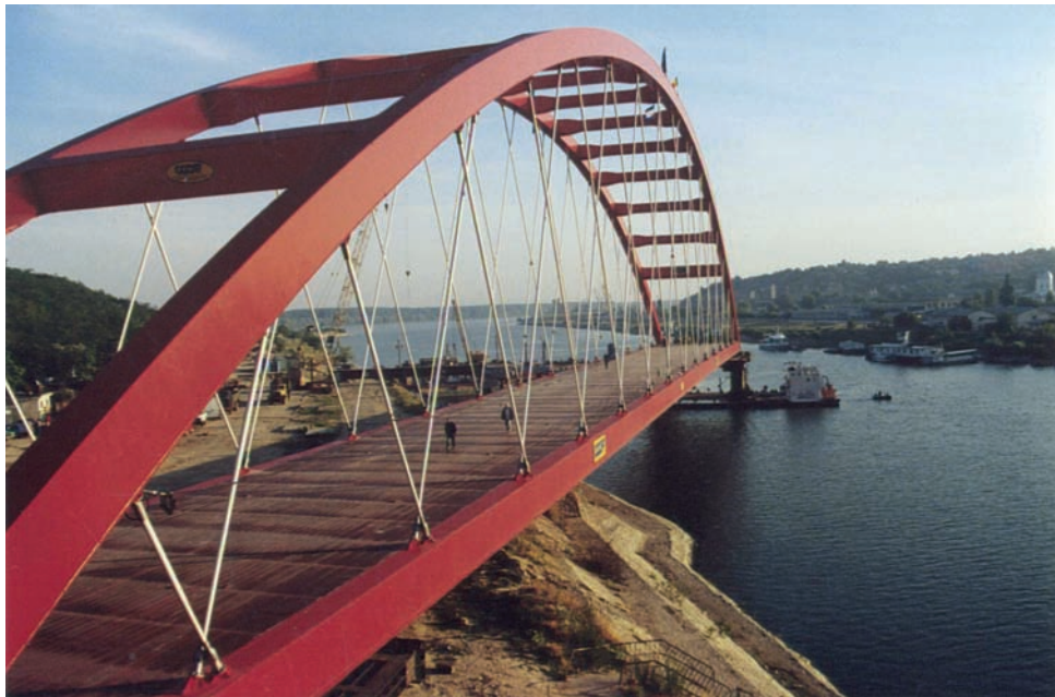
Podul de la Cernavodă, peste Canalul Dunăre-Marea Neagră, în faza de încercare
