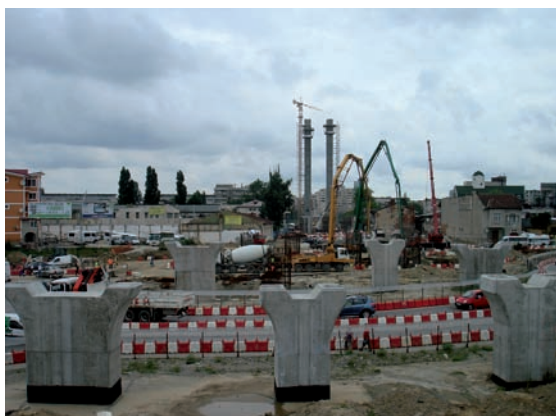
Fig. 5. Elevații pile curente
