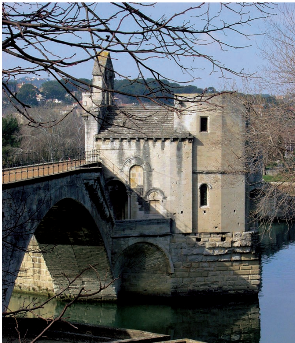
Fig. 3-02. Capela podului peste Ron la Avignon
