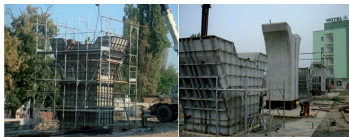
Fig. 3. Cofraje elevații pile curente
