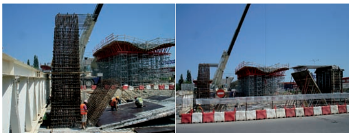
Fig. 6. Armare pila culee PS2
