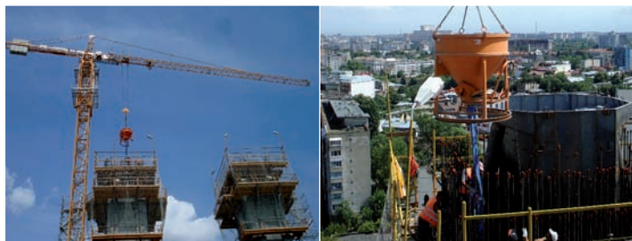
Fig. 24. Betonare stâlpi cu bena cu furtun
