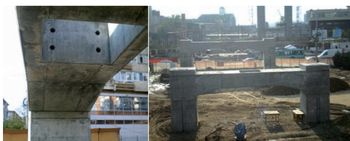
Fig. 14. Gol în riglă la pilele culeei PC3, respectiv PC4, pentru montarea dispozitivului antiseismic
