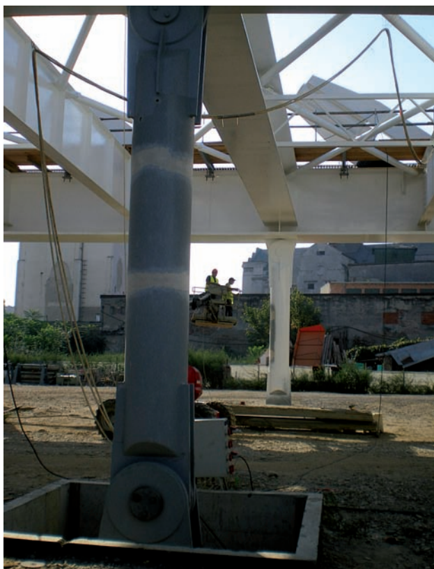
Fig. 35. Tiranți la pila PC1
