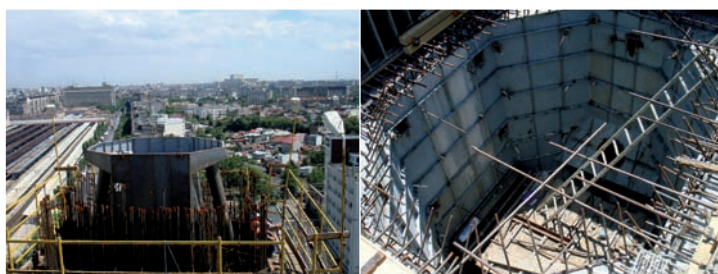
Fig. 29. Cofraje pierdute din metal pe zona ancorajelor
