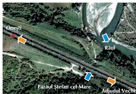
Fig. 3-18. Imagine din satelit: amplasamentul podului Ștefan Cel Mare, lucrare declarată monument Istoric, realizată în timpul domniei Voievodului 1457
