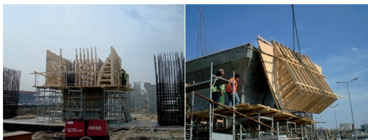
Fig. 16. Cofraj elevație pilă ciupercă
