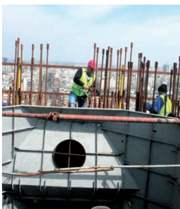
Fig. 29. Cofraje pierdute din metal pe zona ancorajelor
