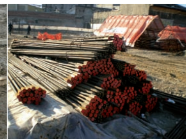
Fig. 26. Bare drepte din BST500 cu manșoane filetate
