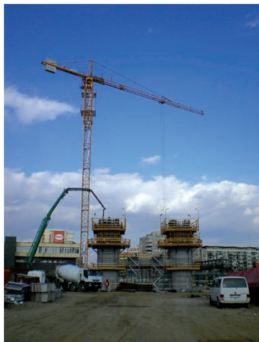
Fig. 23. Betonare stâlpi cu pompa la înălțime mai mică de 25,00 m
