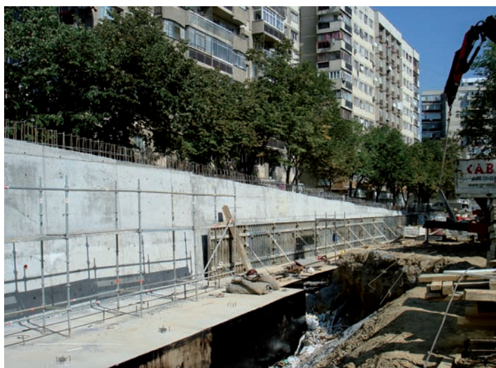
Fig. 38. Zid de sprijin la pila culee SP2
