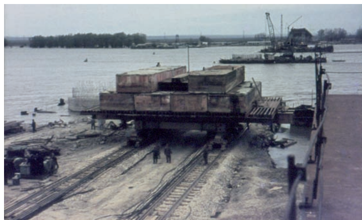
Foto 9. Verificare cale de lansare
