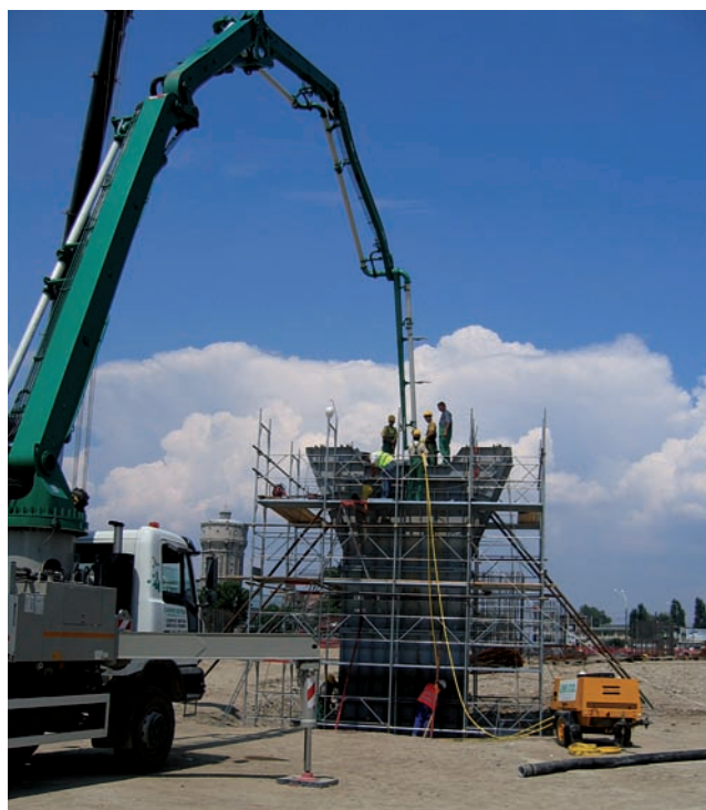
Fig. 4. Betonare pilă
