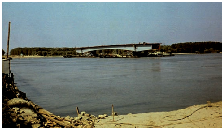
Foto 13 -14. Transferul la apă, navigația și montajul blocului de 218 m Vadu Oii
