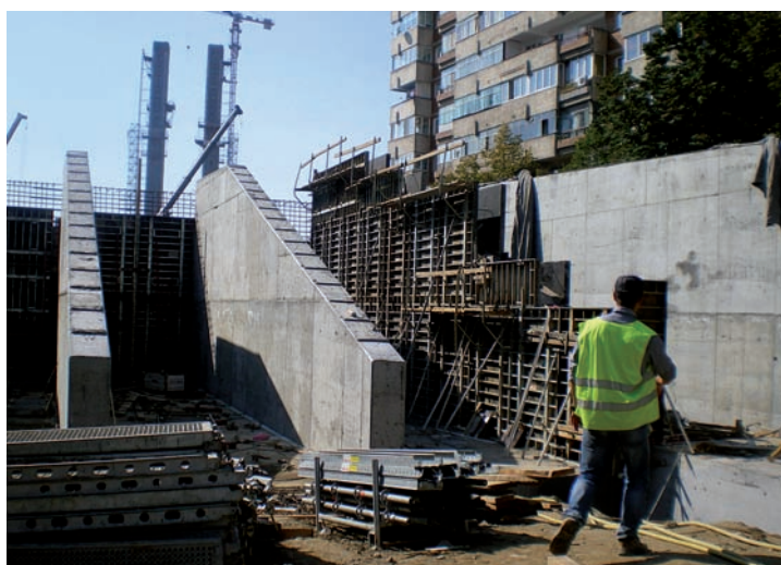
Fig. 37. Ziduri înțoarse și ranforți la culeea Titulescu
