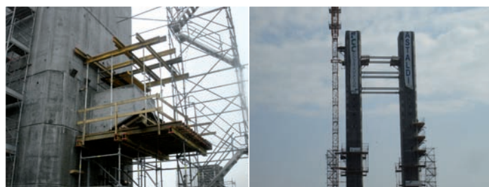
Fig. 19. Consolă pe care reazemă grinzile principale Fig. 20. Grinzi transversale pentru solidarizarea stâlpilor
