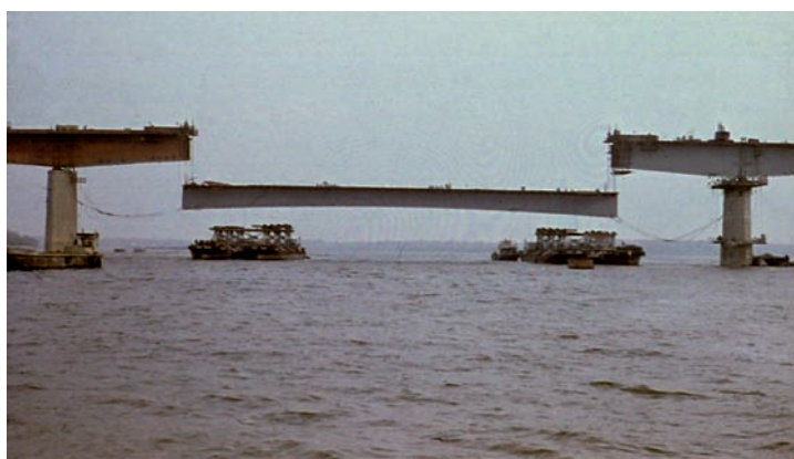
Foto 15-16. Transferul pe apă, navigația și ridicarea la nivel a blocului de 102 m
