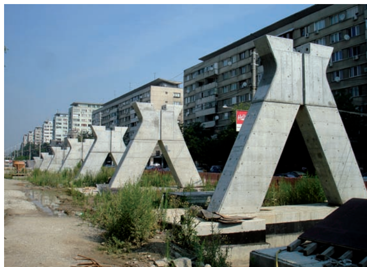
Fig. 31. Elevații pile la rampa de urcare Grivița
