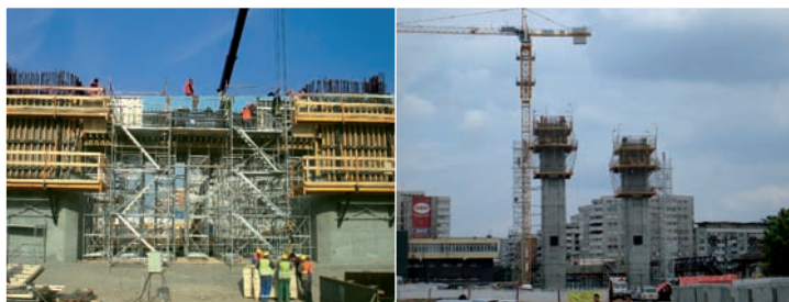
Fig. 28. Cofraje tip pășitoare la exterior
