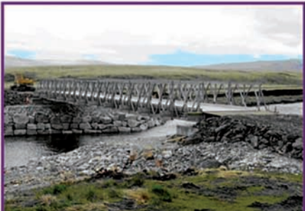
structuri metalice modulare pentru poduri cu deschideri mari și situații critice
