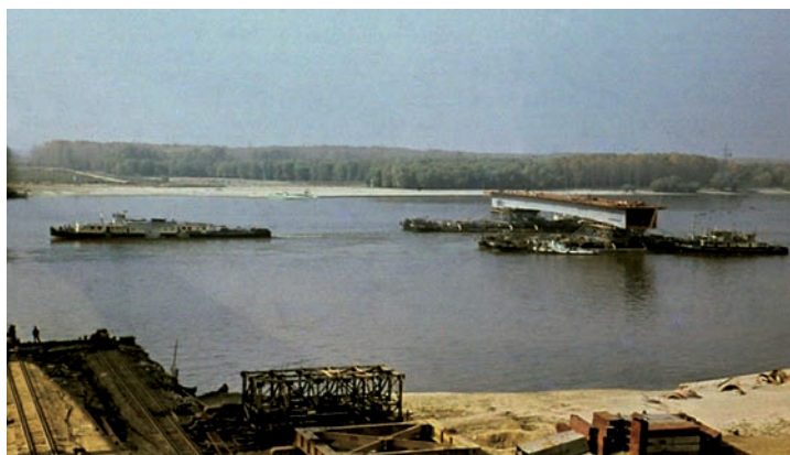
Foto 13 -14. Transferul la apă, navigația și montajul blocului de 218 m Vadu Oii
