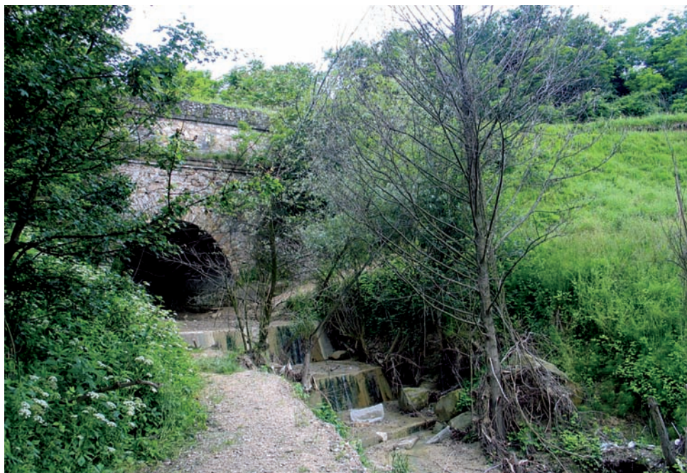
Fig. 3-21. Elevația podului boltit construit pe timpul domniei lui Ștefan cel Mare (1457 – 1504). (foto Sabin Florea)
