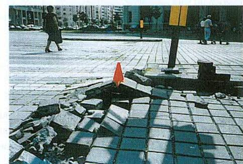
În dalele țărăilor din beton de ciment rutiere și aeroportuare, dilatarea termică generează eforturi interioare de compresiune, iar contractia termică a betonului conduce în final la apariția eforturilor interioare de întindere.
