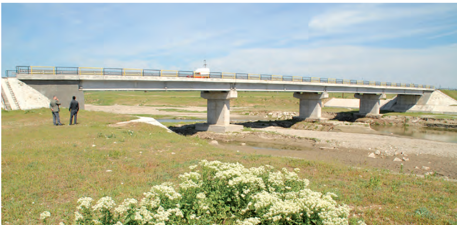
Pod peste râul Vedea la Mavrodin, pe DJ 703, km 159+337
