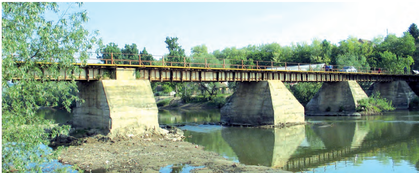
Vedere generală din amonte
