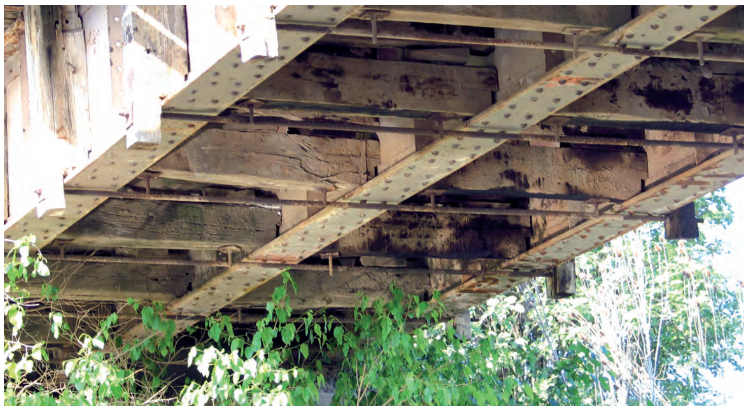
Detaliu de suprastructură grinzi metalice cu inimă plină, simplu rezemate
