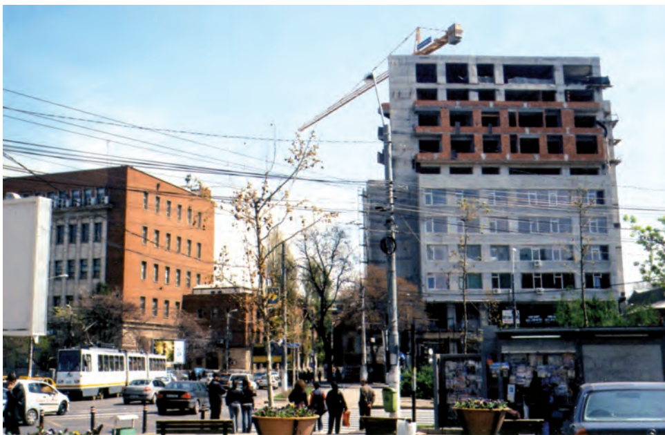
Foto 2 - Intersecția Poșta Vitan Construcție - Dudești Nr. 94
