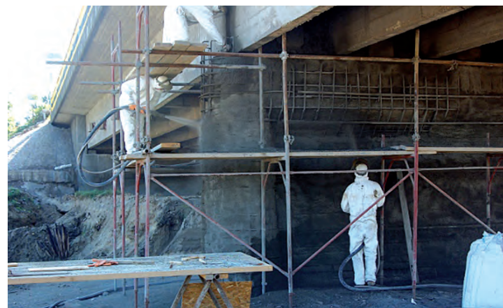
Foto 4 - Procesul de aplicare a torcretatului uscat
