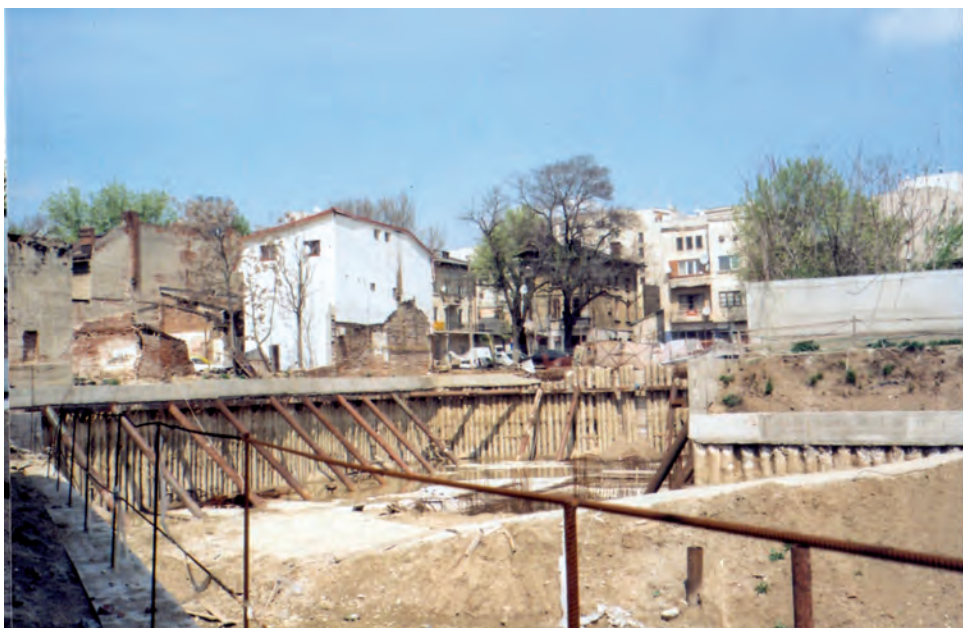
Foto 3 - Hotel Evia Dudești 144-146 - Escavații subsol
