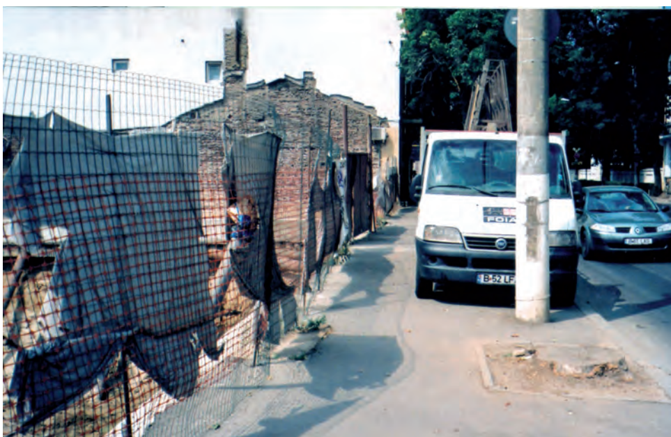
Foto 4 - Hotel Evia - Escavații la limita trotuarului Calea Dudești
