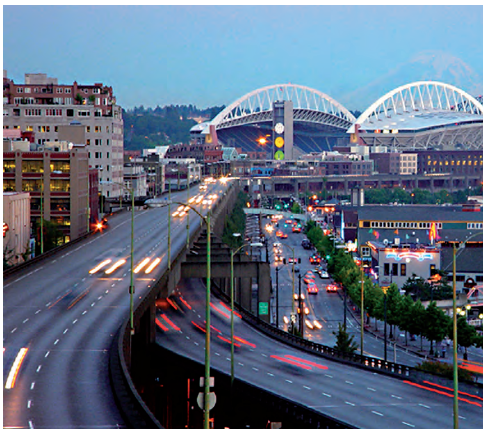
Viaductul Alaskan: construit în anul 1953 și afectat de cutremurul din anul 2001
