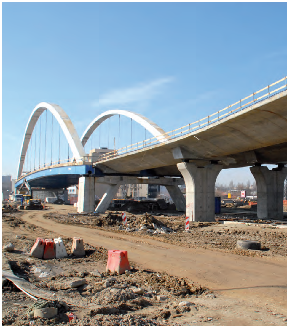
Pasajul Basarab, în construcție
