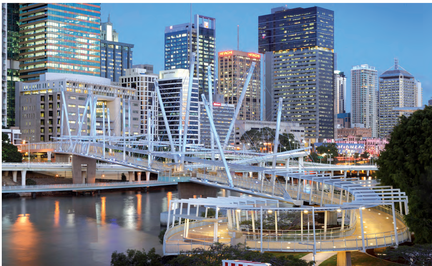
Principiile „tensegrity” aplicate cu succes la acest pod
