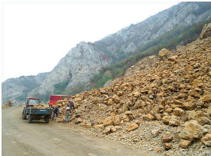
*Materialul rezultat din exploziile din cariera de calcar pentru rambleere, sectorul "Fețele Dunării", 2004*
