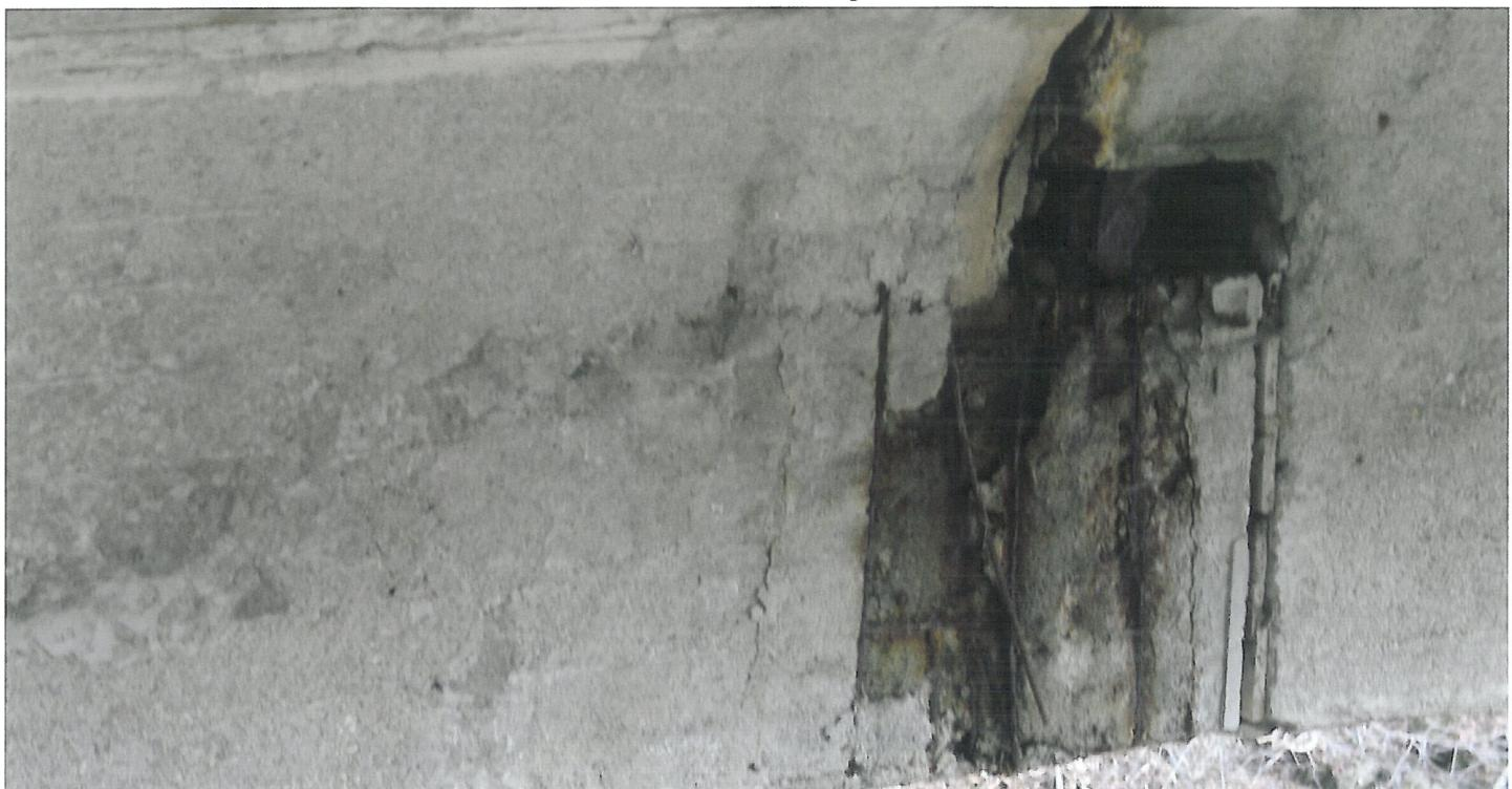
*Rezemare grindă independentă pe grinzi cu console*
