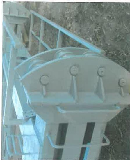
Fig. 4 și Foto 8. Detaliu rezemare și blocare cabluri portante
