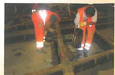
Produse bituminoase pentru sigilarea rosturilor și îmbinărilor, inclusiv materiale turnate la cald (Tok Melt), materiale puse în operă la rece (Tok Plast) și benzi bituminoase (Tok Band Spezial și Tok Band SK)
