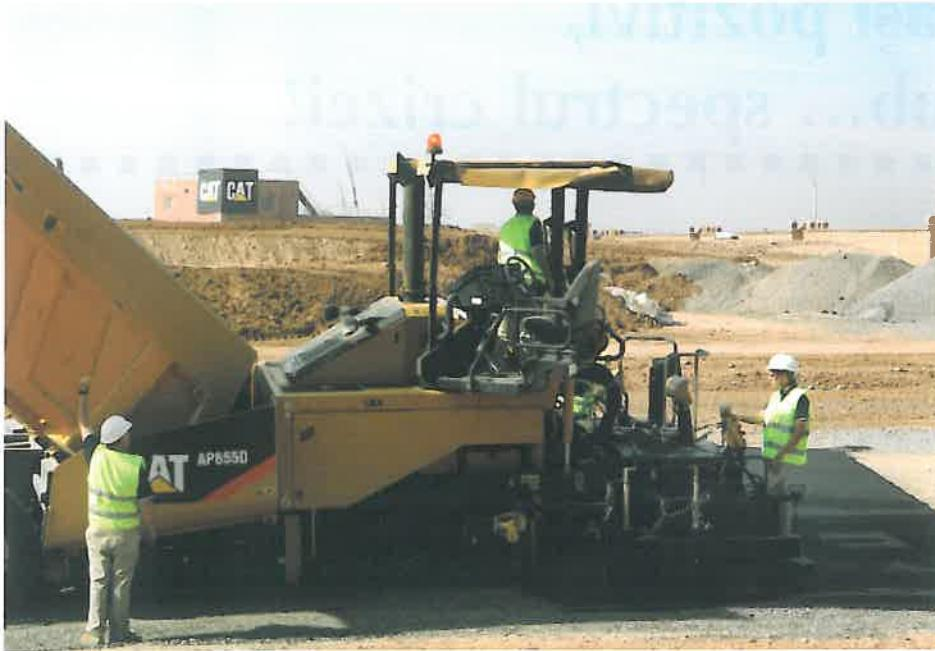
plată cât și cu suprafață profilată. Ambele tipuri de șenile au grosimea de 58 mm și asigură o suprafață de contact generoasă cu suprafața de lucru, datorită lungimii de 3020 mm și lățimii de 406 mm.
