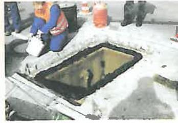
Mortare poliuretanice elastice pentru umplerea rosturilor expuse la sarcini dinamice sporite, ca de exemplu în construcția căminelor de vizitare (Densolastic EM)
