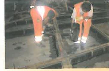
Compuși poliuretanici și produse bituminoase pentru izolarea şinelor de tramvai, absorția vibrațiilor și reducerea zgromotului
