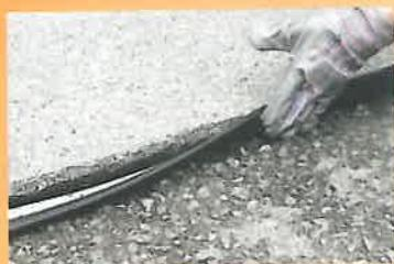
Produse bituminoase pentru sigilarea rosturilor și îmbinărilor, inclusiv materiale turnate la cald (Tok Melt), materiale puse în opera la rece (Tok Plast) și benzi bituminoase (Tok Band Spezial și Tok Band SK)
