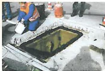
Mortare poliuretanică elastică pentru umplerea rosturilor expuse la sarcini dinamice sporite, ca de exemplu în construcția căminelor de vizitare (Densolastic EM)
