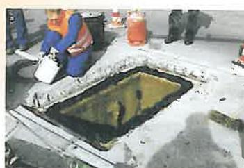
Mortare poliuretanică elastică pentru umplerea rosturilor expuse la sarcini dinamice sporite, ca de exemplu în construcția căminelor de vizitare (Densolastic EM)
