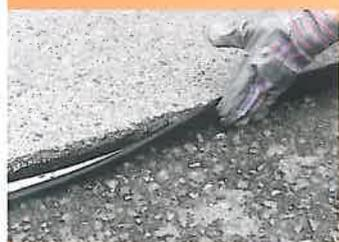
Produse bituminoase pentru sigilarea rosturilor îmbinărilor, incluzând materiale turnate la cald (Tok Melt), materiale folosite în operă la rece (Tok Plast) și benzi bituminoase (Tok Band) și Tok Band Special și Tok Band SK
