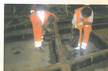
Compuși poliuretatici și produse bituminoase pentru izolarea șinelor de tramvai, absorbția vibrațiilor și reducerea zgomotului
