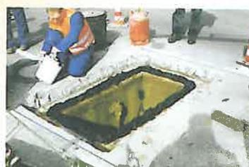
Mortare poliuretanic elastice pentru umplerea rosturilor expuse la sarcini dinamice sporite, ca de exemplu în construcția căminelor de vizitare (Densolastic EM)
