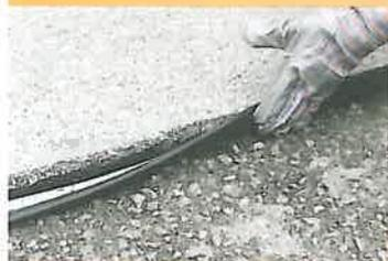
Produse bituminoase pentru sigilarea rosturilor și îmbinărilor, incluzând materiale turnate la cald (Tok Melt), materiale guse în operă la rece (Tok Plast) și benzi bituminoase (Tok Band special și Tok Band SK)
