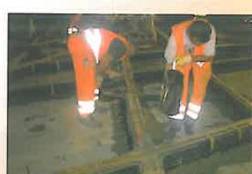
Compuși poliuretanici și produse bituminoase pentru izolarea řinelor de tramvai, absorția vibrațiilor și reducerea zgomotului
