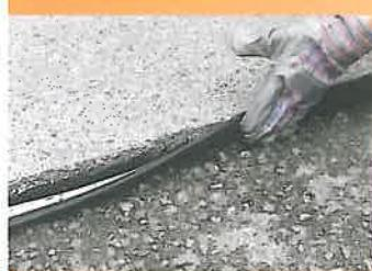
roduse bituminoase pentru sigilarea rosturilor îmbinărilor, incluzând materiale turnate la cald (Tok Melt), materiale use în operă la rece (Tok Plast) și benzi bituminoase (Tok Band special și Tok Band SK)
