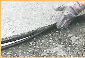
Produse bituminoase pentru sigilarea rosturilor și îmbinărilor, inclusiv și materiale turnate la cald (Tok Melt), materiale puse în opera la rece (Tok Plast) și benzi bituminoase (Tok Band Spezial și Tok Band SK)
