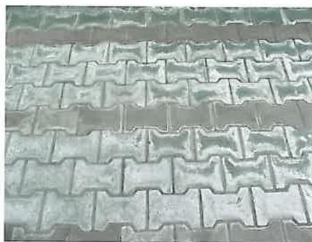
titate excedentară de apă, în condițiile unei evaporări accelerate la vârste fragede. Raportul A/C mare precum și lipsa tratării corespunzătoare a betonului sporesc porozitatea acestuia.
