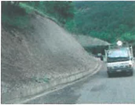
**Fig. 2. Hidroînsămânțare. Taluz în timpul pulverizării**
