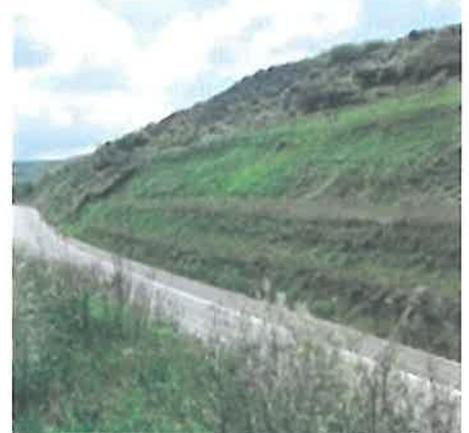
**Fig. 11. Realizarea stabilizării terenului prin îmbinarea tehnologiei PRATI ARMATI® cu terenuri armate la Val d'Ultimo (BZ), Italia**
