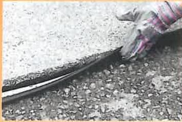
Produse bituminoase pentru sigilarea rosturilor și îmbinărilor, incluzând materiale turnate la cald (Tok Melt), materiale puse în operă la rece (Tok Plast) și benzi bituminoase (Tok Band Spezial și Tok Band SK)
