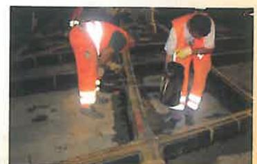
Compuși poliuretanic și produse bituminoase pentru izolarea șinelor de tramvai, absorbția vibrațiilor și reducerea zgomotului
