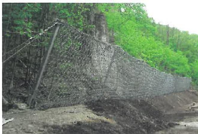
Fig. 9. Bariera RX-300 instalată, cu capacitatea de a absorbi energii de 3000 kJ
