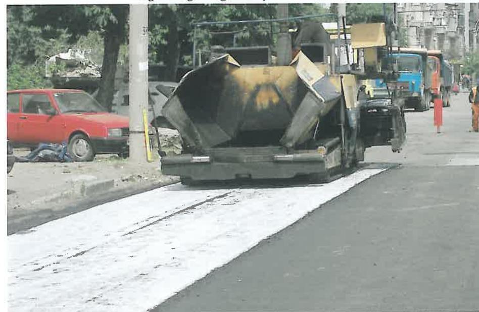
Fig. 8. Așternerea mixturii peste geocompozit (2004)
