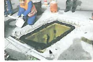
Mortare poliuretanice elastice pentru umplerea rosturilor expuse la sarcini dinamice sporite, ca de exemplu în construcția căminelor de vizitare (Densolastic EM)
