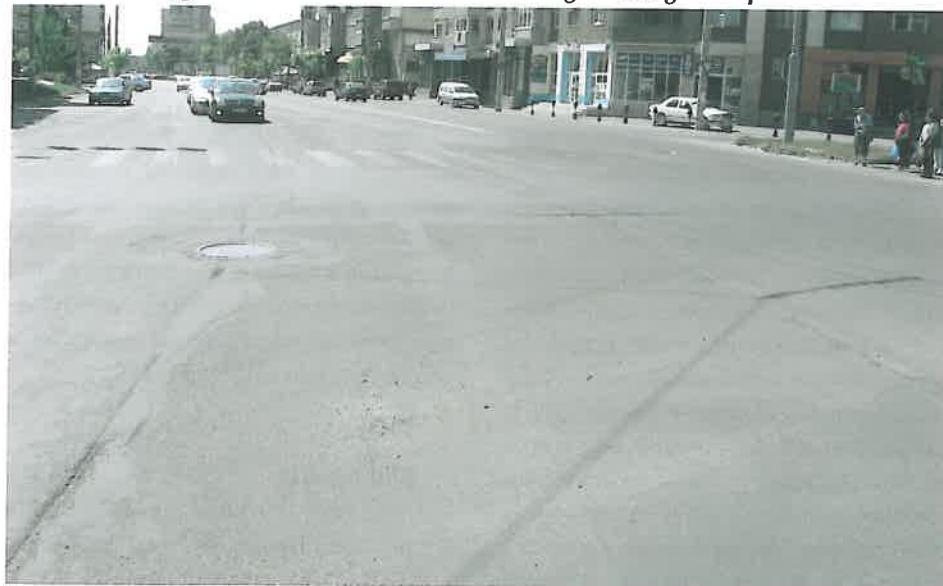
Fig. 12. Ranforsare structură rutieră rigidă fără geocompozit
