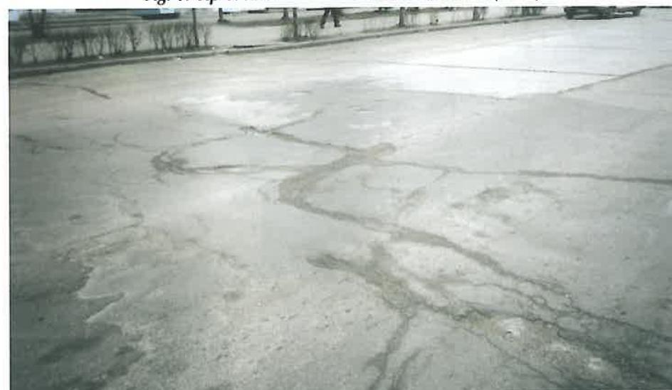
Fig. 2. Zona de racord Sector ranforsat - sector neranforsat (2004)
