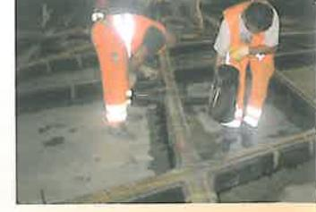
Compuși poliuretanici și produse bituminoase pentru izolarea șinelor de tramvai, absorția vibrațiilor și reducerea zgomotului
