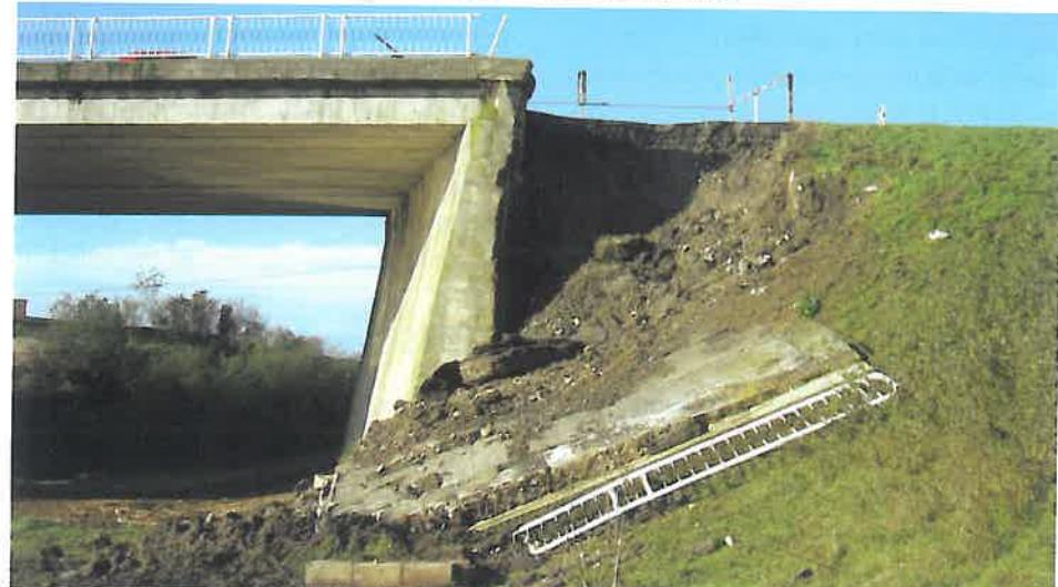
Fig. 2. Degradări ale zidurilor întoarse
