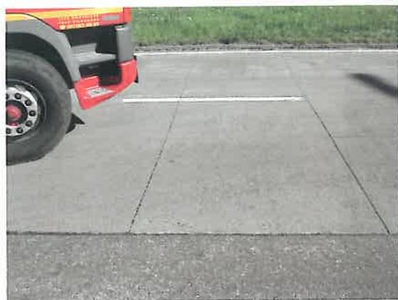
Îmbrăcămintea din beton protejează asfaltul de uzură, șocuri termice și îmbătrâniere accelerată crescând durabilitatea acestuia. Avantajele acestei structuri compozite sunt rezistența crescută la uzură și sarcina aplicată static, sensibilitatea redusă la variații de temperatură, rezistență la foc, culoarea deschisă și nu în ultimul rând costurile reduse de întreținere, specifice îmbrăcămintelor rigide.
