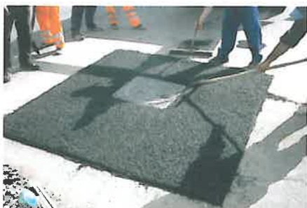
Foto 14 - 15. Aplicarea benzii autoadezive TOK Band SK pe suprafața rostului și pe fața laterală a ramei capacului. Acest produs din bitum modificat cu polimeri asigură etanșarea perfectă a rostului. Are o față autoadezivă, care aderă la suprafețele „reci” amorsate în prealabil, iar fața opusă fuzionează cu bitumul din asfaltul care se folosește pentru închiderea suprafeței
