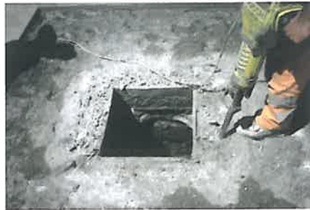
Foto 5. Se înlătură stratul de beton degradat din placă
