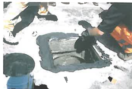
Foto 11 - 12. Rama capacului se echipează cu profile pătrate fixate pe fața superioară. Este indicat ca lungimea acestor profile să depășească cu câțiva cm. deschiderea dintre cele două tăieturi opuse executate pentru delimitarea ariei de intervenție, astfel încât prin așezarea ramei echipate cu profile, capetele profilelor să se sprijine pe drum, obținându-se astfel o perfectă aliniere a ramei cu drumul. Se aplică mortarul elastomeric cu ajutorul unei mistrii, în exces, astfel încât prin așezarea ramei capacului, mortarul să umple golul format. Excesul de material va refula și se poate folosi pentru umplerea eventualelor goluri observate
