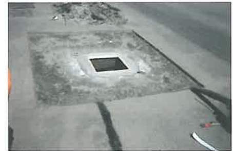
Foto 8 - 9. După amestecare cu ajutorul unui malaxor, mortarul se toarnă imediat. Se urmărește realizarea unei suprafețe plane. În primă fază mortarul este foarte fluid, drept urmare cofrajul trebuie să fie cât mai etanș. După încheierea acestei etape, se vor executa operațiuni de amorsare a fisurilor din jurul zonei de tăiere și a feței rostului de tăiere pentru aplicarea benzii de sigilare a fisurilor Rissband și a benzii de sigilare a rostului TOK Band SK.
