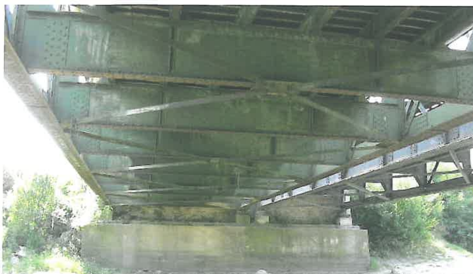
Fig. 2. Alcătuirea platelajului
