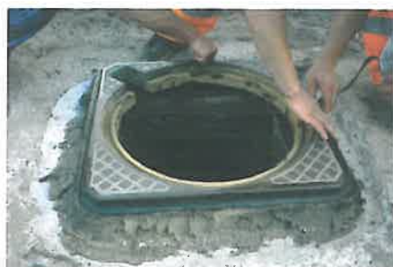
Foto 14 - 15. Aplicarea benzii autoadezive TOK Band SK pe suprafața rostului și pe fața laterală a ramei capacului. Acest produs din bitum modificat cu polimeri asigură etanșarea perfectă a rostului. Are o față autoadezivă, care aderă la suprafețele „reci” amorsate în prealabil, iar fața opusă fuzionează cu bitumul din asfaltul care se folosește pentru închiderea suprafeței
