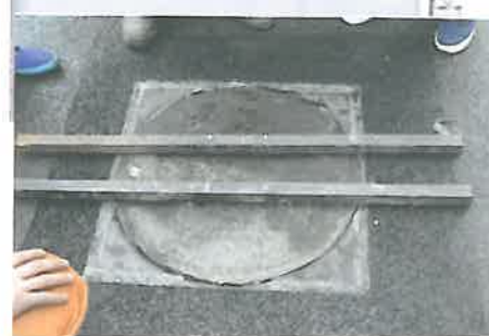
Foto 3. Se așează capacul la nivel
