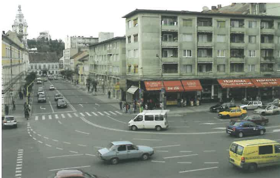
Intersecția Piața Lucian Blaga cu str. Petru Maior
