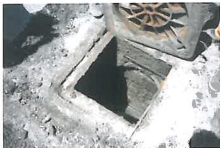
Foto 4. Placa de beton a fost turnată peste vechiul capac de cămin. Pentru fixare la cotă s-au folosit profile striate PC 52
