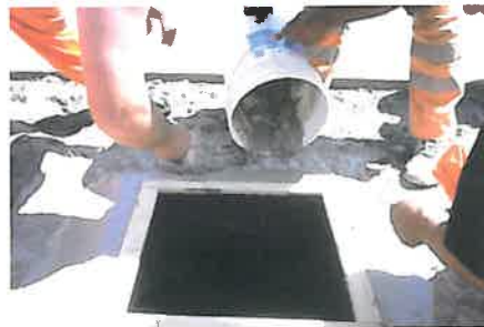
Foto 8 - 9. După amestecare cu ajutorul unui malaxor, mortarul se toarnă imediat. Se urmărește realizarea unei suprafețe plane. În primă fază mortarul este foarte fluid, drept urmare cofrajul trebuie să fie cât mai etanș. După încheierea acestei etape, se vor executa operațiuni de amorsare a fisurilor din jurul zonei de tăiere și a feței rostului de tăiere pentru aplicarea benzii de sigilare a fisurilor Rissband și a benzii de sigilare a rostului TOK Band SK.
