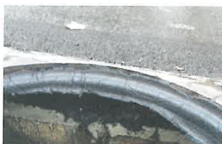
Foto 4. Excesul de material refulează, umple golurile și formează o garnitură perfectă
