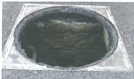
Foto 1. După preparare, se aplică mortarul Densolastic cu ajutorul unei mistrii, în exces pe conturul de așezare al capacului
