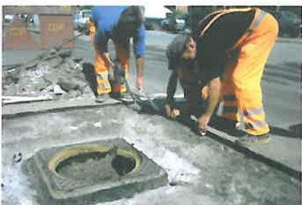
Foto 14 - 15. Aplicarea benzii autoadezive TOK Band SK pe suprafața rostului și pe fața laterală a ramei capacului. Acest produs din bitum modificat cu polimeri asigură etanșarea perfectă a rostului. Are o față autoadezivă, care aderă la suprafețele „reci” amorsate în prealabil, iar fața opusă fuzionează cu bitumul din asfaltul care se folosește pentru închiderea suprafeței
