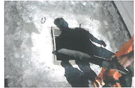
Foto 6. Curățarea suprafeței cu ajutorul unei suflante
