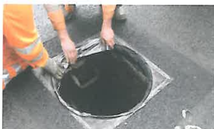
Foto 2. Se aplică o folie subțire de polietilenă pentru evitarea lipirii capacului
