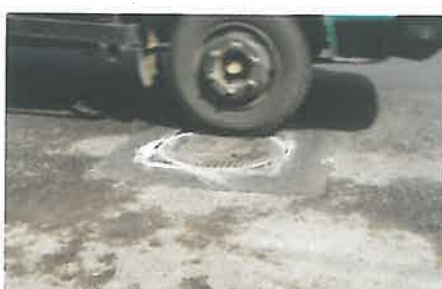
Foto 5. Trafic greu, după o oră de la finalizarea lucrării
