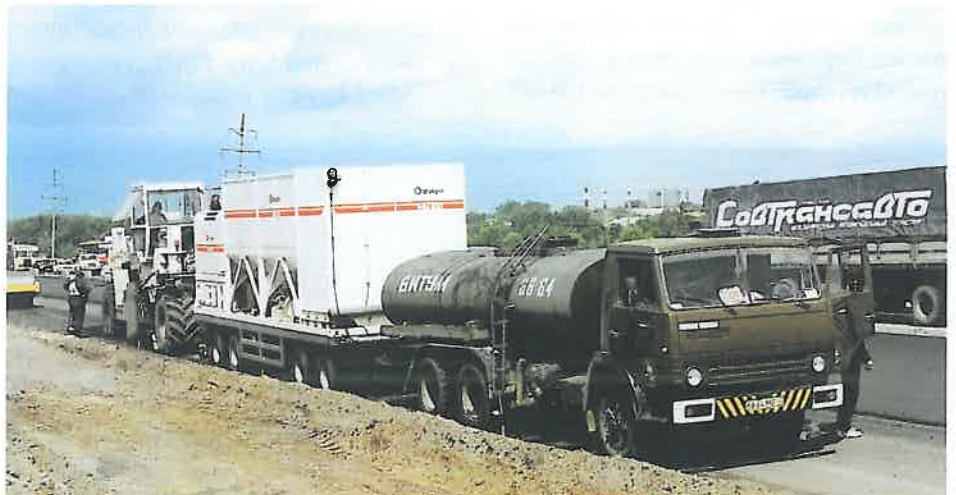
Reciclarea la rece a unei benzi de 2,5 m, cu adaos de emulsie bituminoasă și suspensie de ciment
