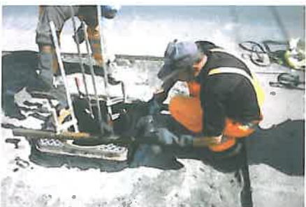
Foto 13. Umplerea golurilor cu ajutorul materialului refulat. În acest caz profilele fiind mai scurte, au fost așezate pe distanțieri
