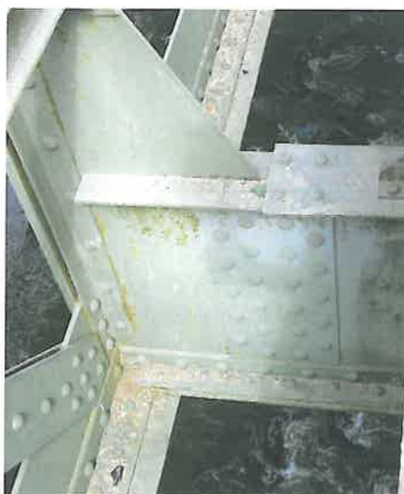
Fig. 4. Detaliu prindere antretoaze de grinzile principale
