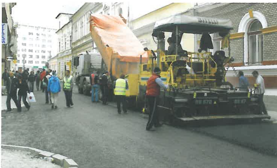
Se toarnă mixtură asfaltică pe str. Emil Isac
