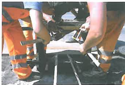
Foto 11 - 12. Rama capacului se echipează cu profile pătrate fixate pe fața superioară. Este indicat ca lungimea acestor profile să depășească cu câțiva cm. deschiderea dintre cele două tăieturi opuse executate pentru delimitarea ariei de intervenție, astfel încât prin așezarea ramei echipate cu profile, capetele profilelor să se sprijine pe drum, obținându-se astfel o perfectă aliniere a ramei cu drumul. Se aplică mortarul elastomeric cu ajutorul unei mistrii, în exces, astfel încât prin așezarea ramei capacului, mortarul să umple golul format. Excesul de material va refula și se poate folosi pentru umplerea eventualelor goluri observate
