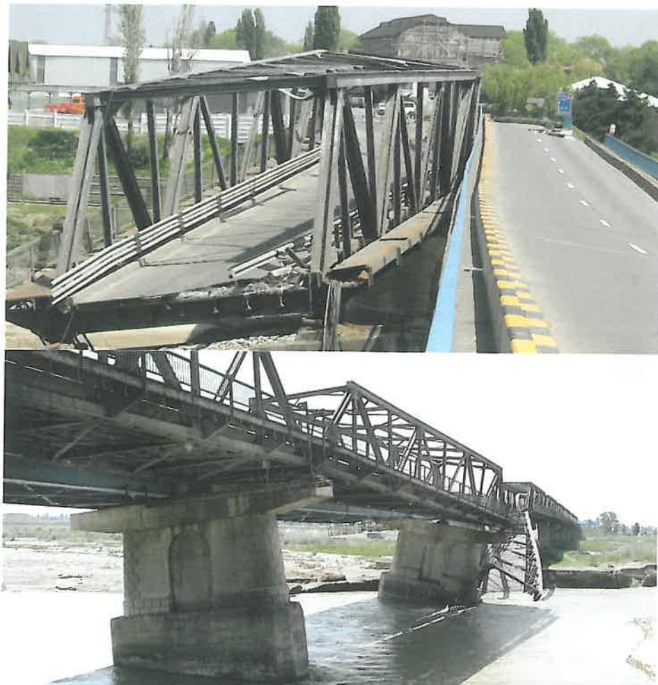
**Fig. 3. Pod peste râul Buzău la Mărăcineni după inundațiile din 2005**
