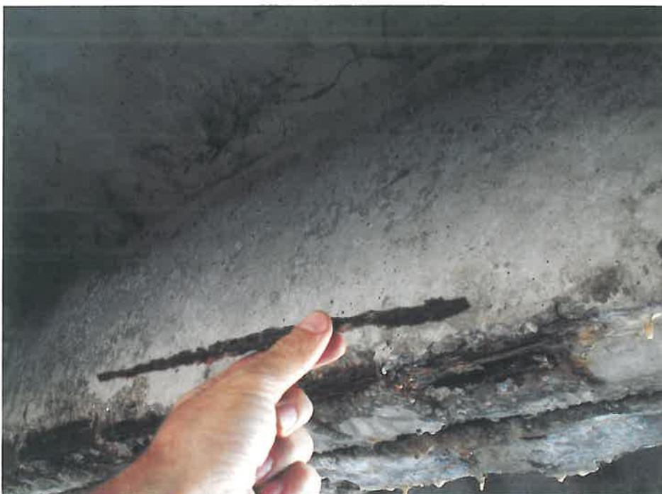
**Fig. 1. Armătură cu un grad avansat de coroziune la grinziile din beton armat ale unui pod**
