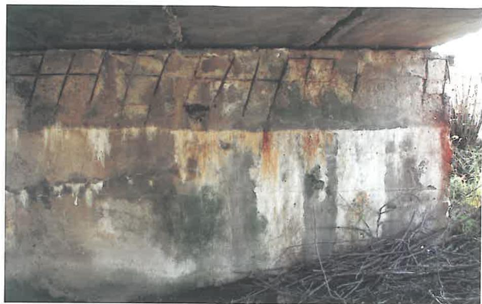
Fig. 11. Carbonatare la culeea din beton armat a unui pod
