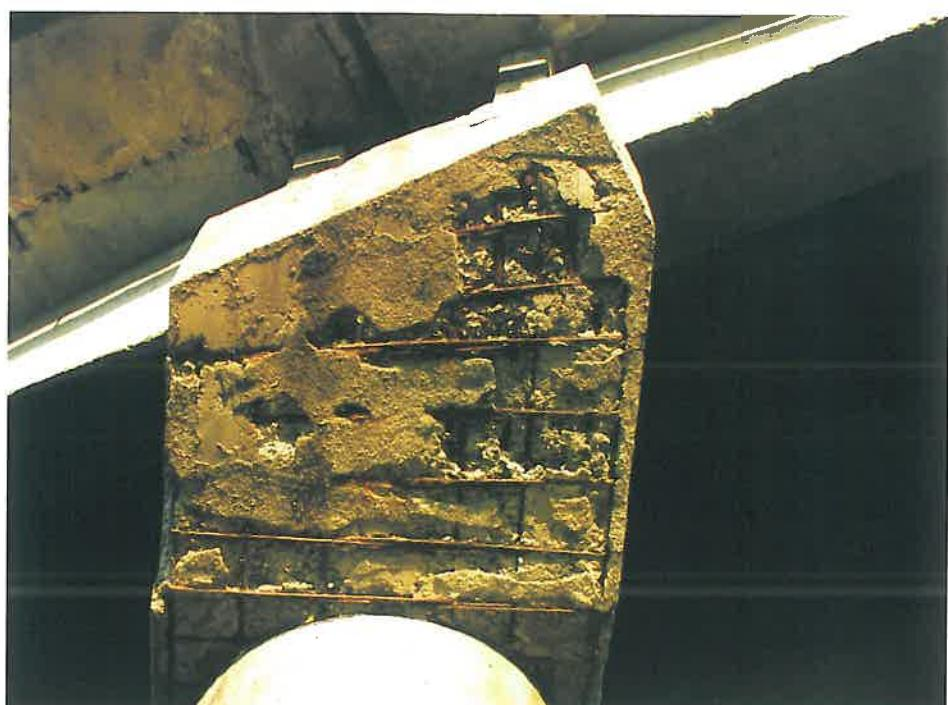
Fig. 6. Armătură cu un grad avansat de coroziune la rigla pilei din beton armat ale unui pod
