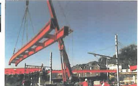
*Fig. 7. Montarea elementelor prefabricate pe sănzier*
