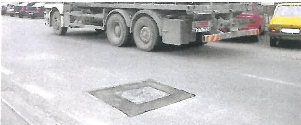
3. Demolarea materialului din jurul capacului metalic propriu-zis, cu ajutorul pi-camerului în vederea îndepărtării de pe poziție. Există și dispozitive speciale pentru demolare.
