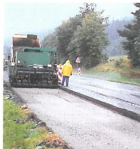
Așternerea unui strat de bază cu liant hidraulic, cu un finisor la 3,0 m lățime
