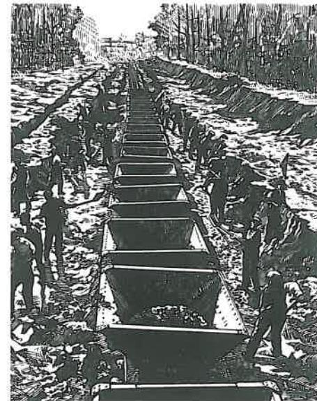
Foto 4. Execuția lucrărilor de terasamente la primele autostrăzi din Germania
