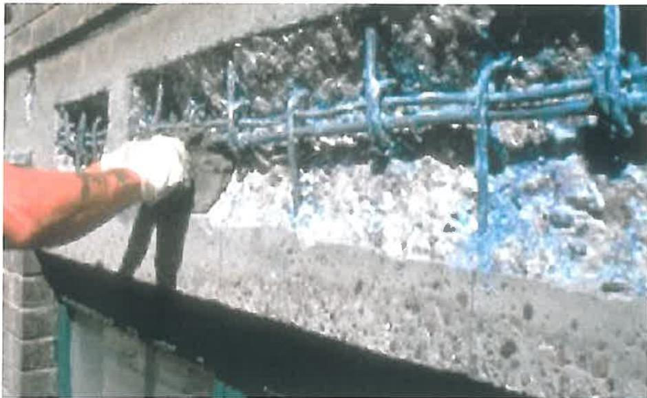
prin tencuire cât și pentru toate tipurile de reparații prin umplere. Renderoc GP este de natură alcalină și protejează armătura din metal încorporată, dezvoltând o rezistență la compresiune de 28 N/mm<sup>2</sup> la 28 de zile. Mortarul este potrivit acolo unde sunt necesare rezistențe mari la cloruri și dioxid de carbon.
