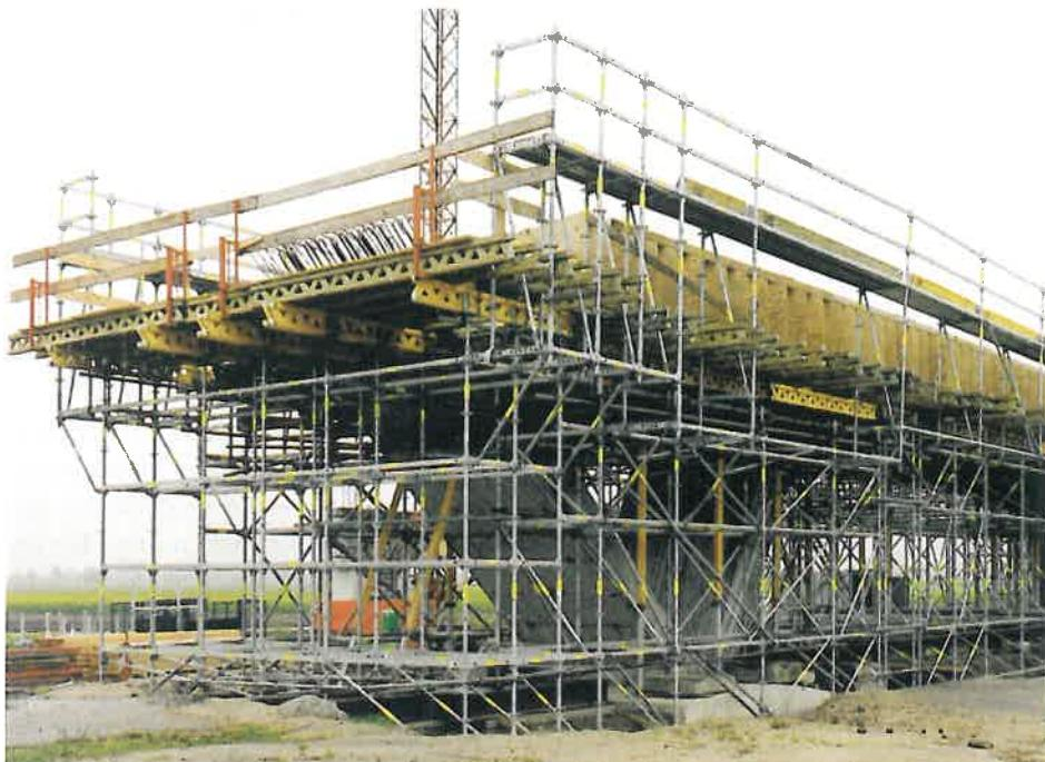
Fig. 4. Echipamente tehnologice de cofrare
