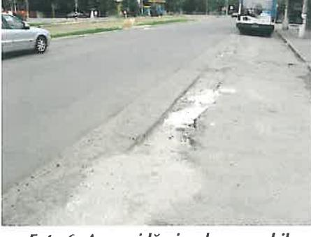
Foto 6. Aceeași lărgire de carosabil compromisă (ce ar fi putut fi evitată dacă înainte de a se trece la partea de structură ar fi existat un mijloc pentru controlul terasamentului).
