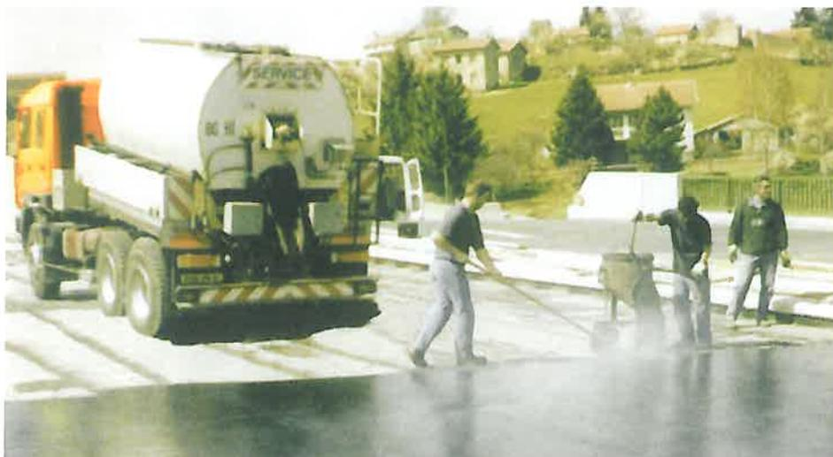
Fig. 1. Turnarea mixturii pe șosea
