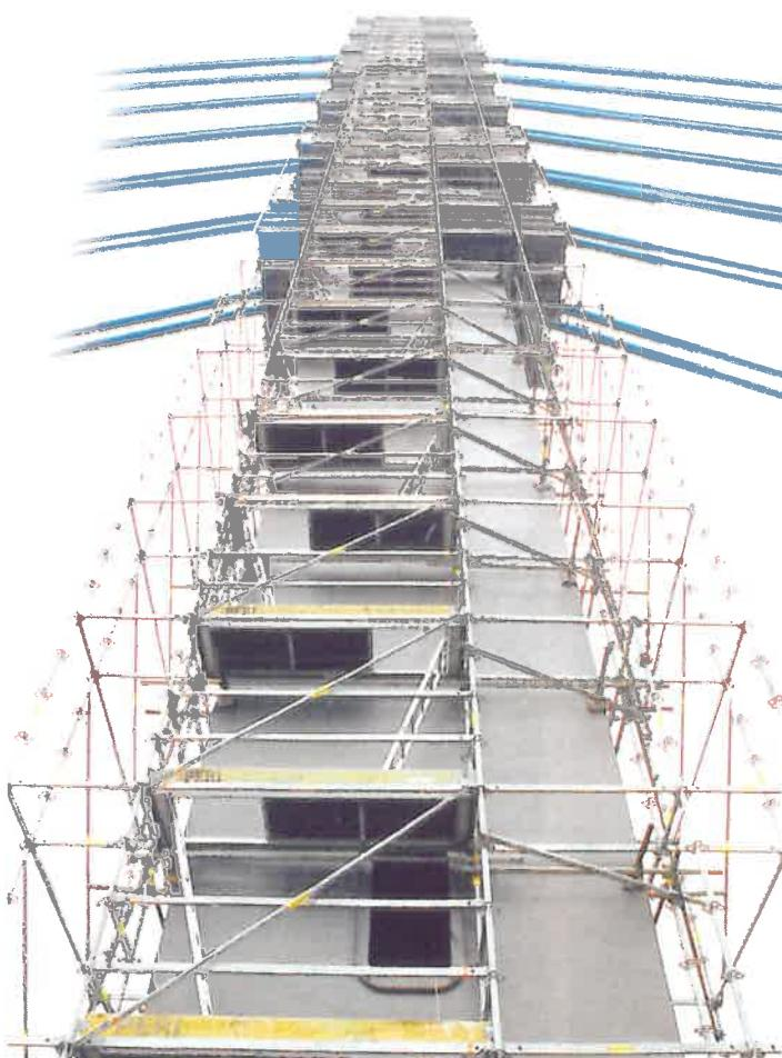
**PERI UP permite montarea optimă pentru nivelele de lucru, utilizând componentele sistemului, necesare pentru ansamblul cablurilor ancorate. Platformele care integrează protecția la deplasare pot fi ușor scoase și reinstalate oriunde pe eșafodaj**
