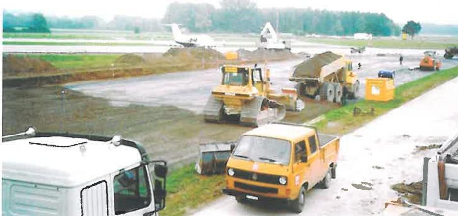
*Fig. 2. Transportul în șantier cu autobasculanta și profilarea materialului cu utilaje specializate (autogreder, buldozer etc.)*
