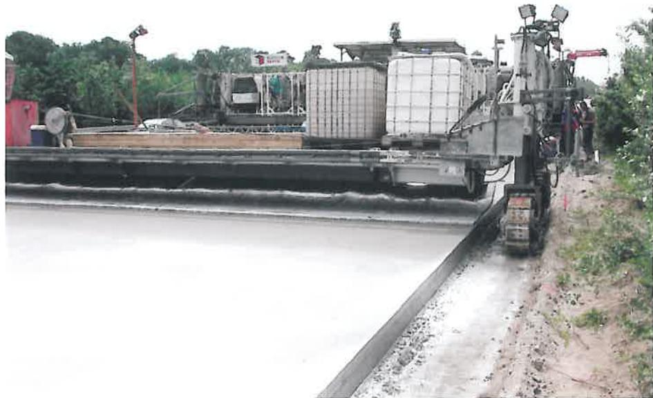
betonul de ciment în îmbrăcăminte rutiere. Structura folosită era alcătuită din dale de beton de ciment de grosime  $\approx 18$  cm pe hârtie tip Kraft, 2 cm nisip pilonat și o fundație din balast de 20 - 25 cm.
