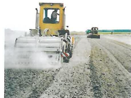
**Fig. 3. Profilare cu echipamente specializate (autogreder, buldozer etc.)**
