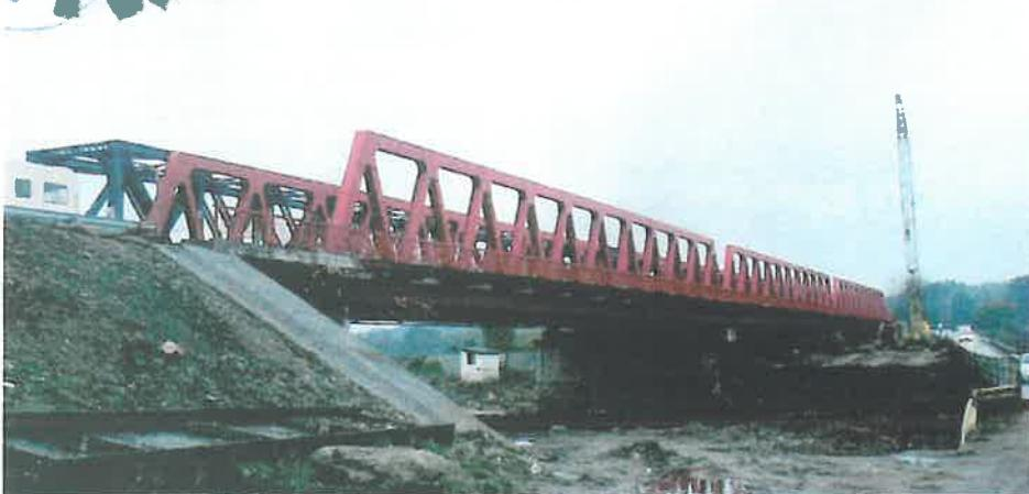
Fig. 2. Suprastructura podului, alcătuită din trei deschideri de căte 55,00 m lungime
