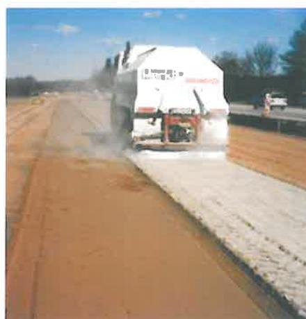
**Fig. 2. Omogenizare amestec cu echipamente specialize (reciclatoare, freze de amestec etc.)**
