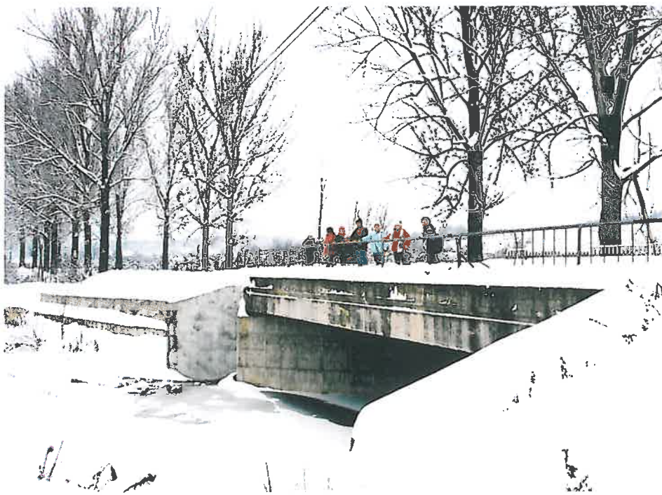
Podul supralărgit și cu consolidări de maluri, de pe D.J. 670 (km 86+300)
