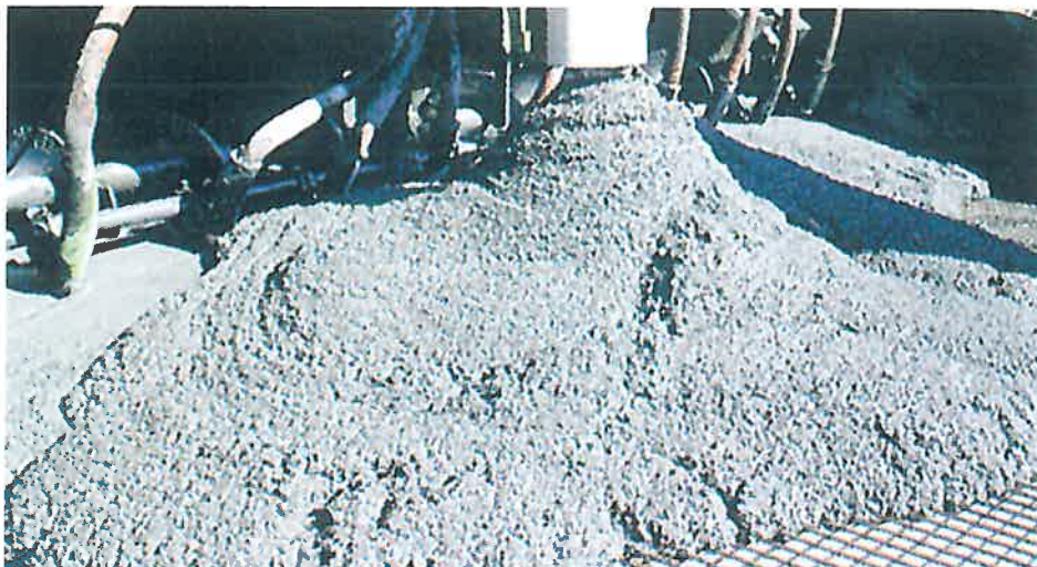
Așternerea betonului din materiale bituminoase frezate pe o secțiune de test
