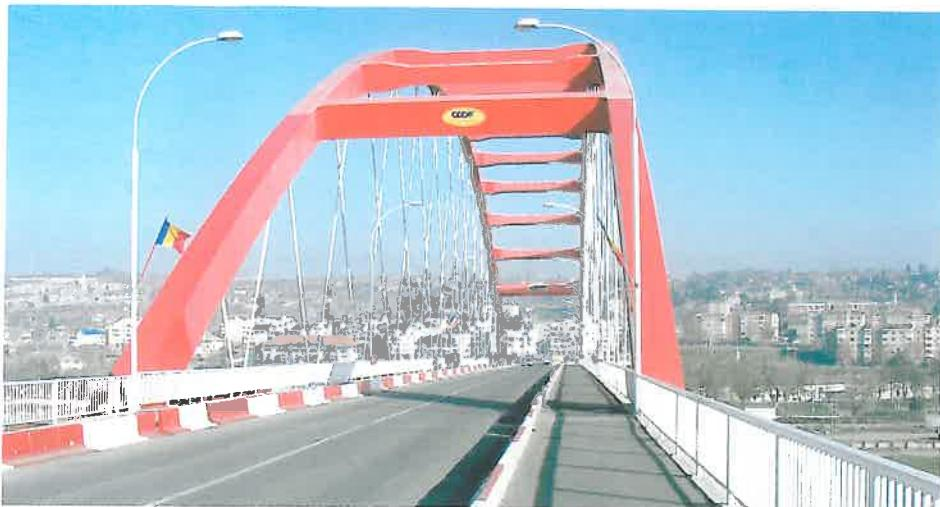
sunt solidarizate prin contravânturi alcătuite din rigle cu secțiune casetată.
