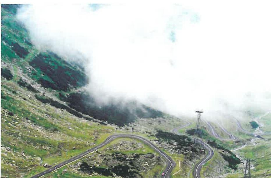
Pe întregul traseu al drumului au fost de executat peste 3,8 milioane m<sup>3</sup> săpătură și pământ, peste 290 mii m<sup>3</sup> zidărie, 27 poduri și viaducte, 550 podețe, 80 km parapeți, 878 m tunel.
