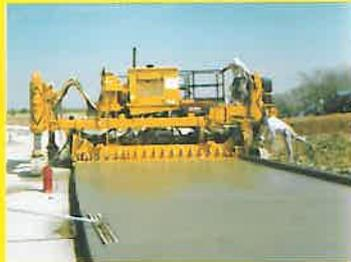
Echipamente pentru realizarea de căi rutiere, rigole, parapeti
