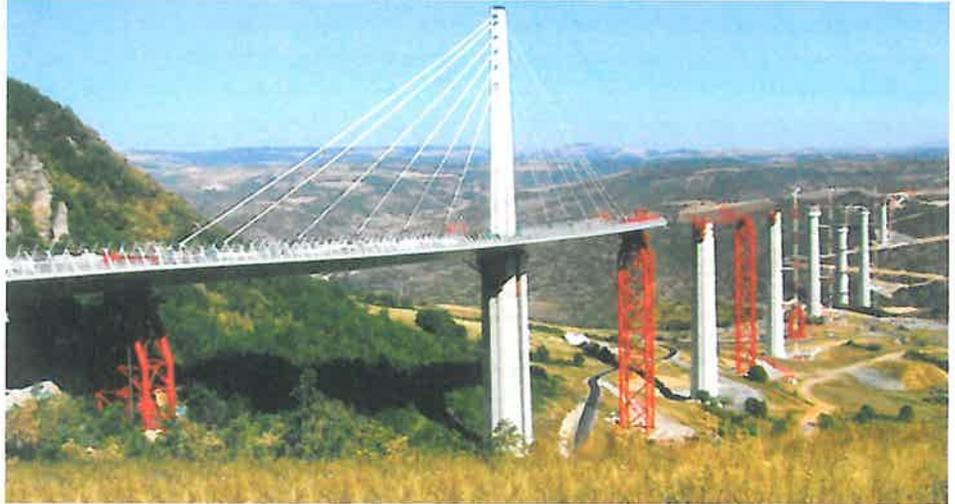
Un sistem hidraulic avansat, care include controlul avansat PLC, a fost proiectat să împingă tablierul cu o lățime de 27,35 m (cu o capacitate de șase benzi de circulație plus acostamente) de pe ambele părți ale văii râului către cele șapte pile de beton ale podului. A fost proiectat și construit de Centrul de excelență în construcții Enerpac din Madrid, Spania. În timpul procesului de începere a lucrării, tablierul a fost sprijinit de șapte pile meta-
