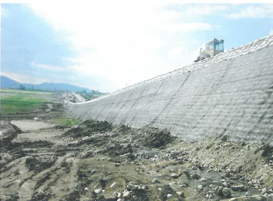
Înălțimea terasamentelor armate cu geogrise fiind mare (de la 5,00 m la 11,00 m) realizarea cofrajelor de formă a paramentului îngreuna considerabil execuția și de aceea a fost adoptat un sistem de zidărie din saci biodegradabili umpluți cu pământ vegetal amestecat cu sămânță de iarba.
