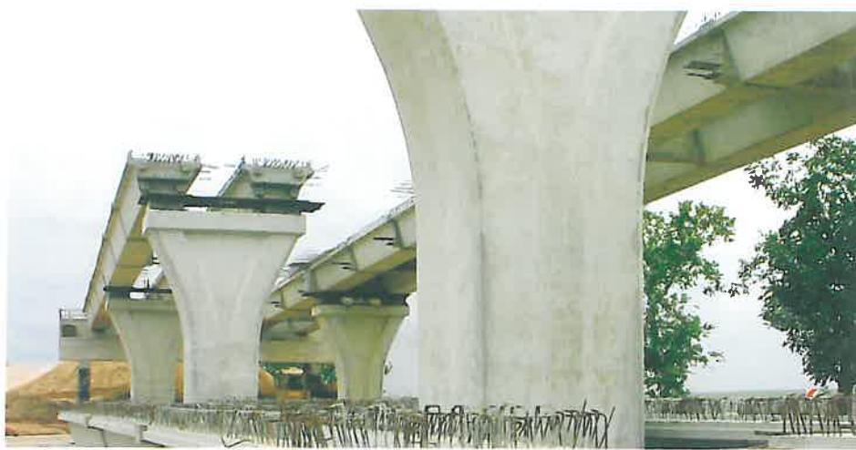
*Grindă lată din tronsoane mari de beton precomprimat, secțiune trapezoidală casetată deschisă la partea superioară în două ipostaze, pusă sub tensiune și montată în deschidere*
