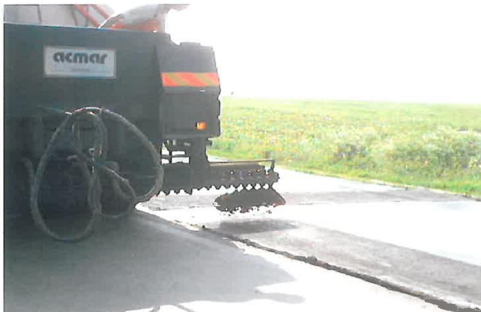
Fig. 4. Amorsarea geocompozitului cu bitum cald
