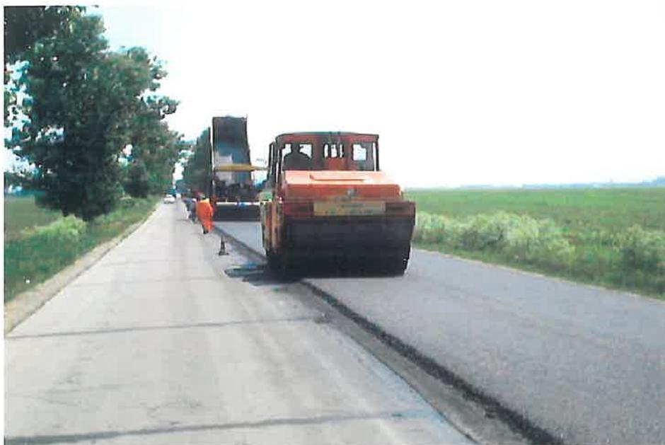
Fig. 5. Așternerea geocompozitului între stratul de ciment și stratul de mixtură asfaltică
