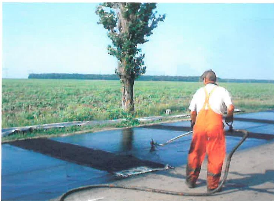
Fig. 3. Aplicarea geocompozitului Bistex la rosturi
