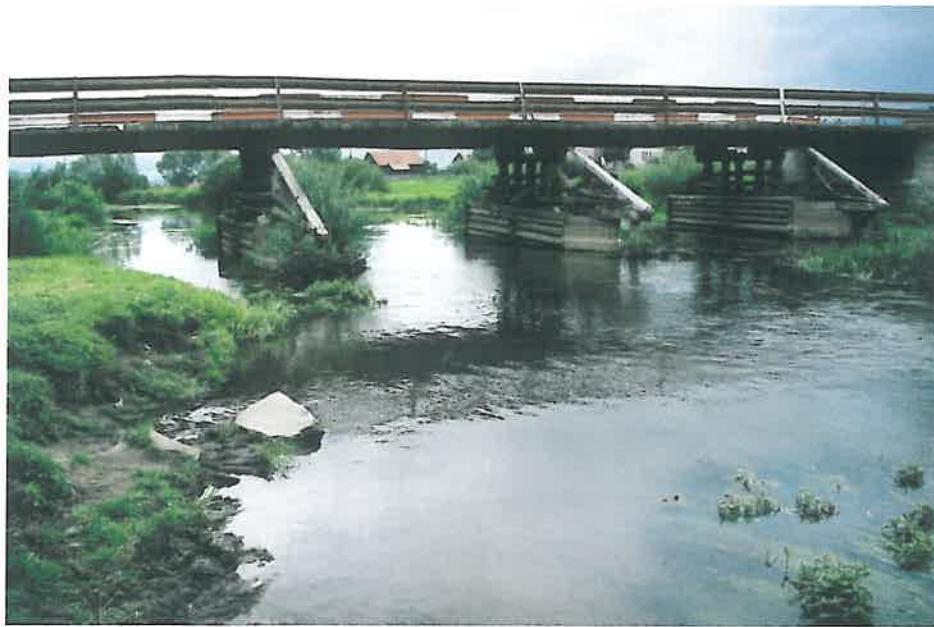
**Podul pe DC 64 (Băile Remetea - Remetea), realizat cu suprastructură din platforme de vagoane**
