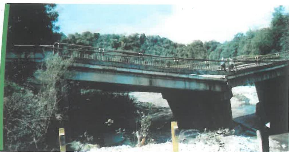
Fig. 2. Pierderea stabilității unei pile datorită afuierilor și coborârii talvegului
