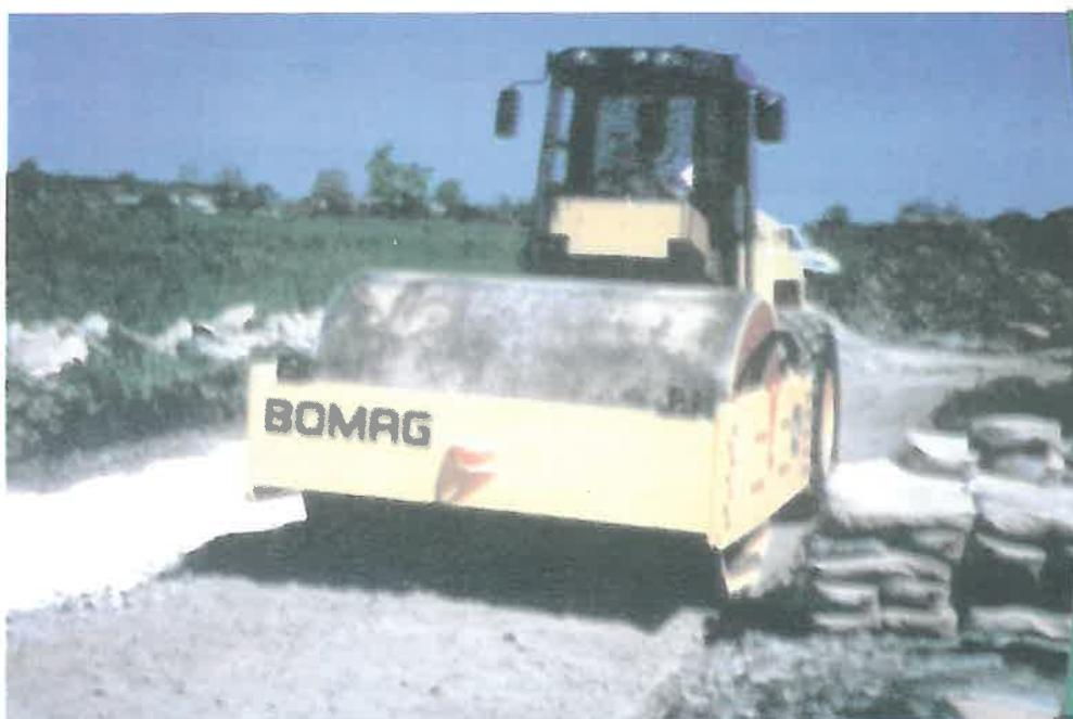
Fig. 4. Compactarea stratului stabilizat
