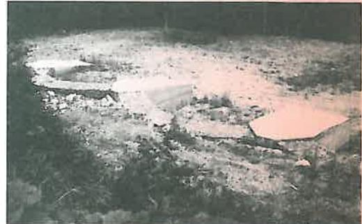
Foto 1. Consolidare taluz aval cu ranforți în săpătură deschisă și bolti din gabioane
