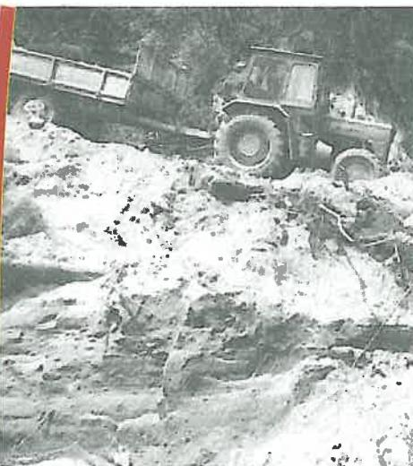
Foto 2. Utilajul folosit pentru transport piatră brută pentru gabioane. Se observă materialul fin depus în lipsa barajului cu fante
